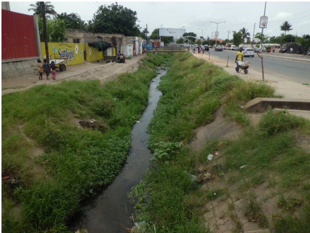
Figura 5.6: Canal principal de drenagem da Av. Acordos de Lusaka.
