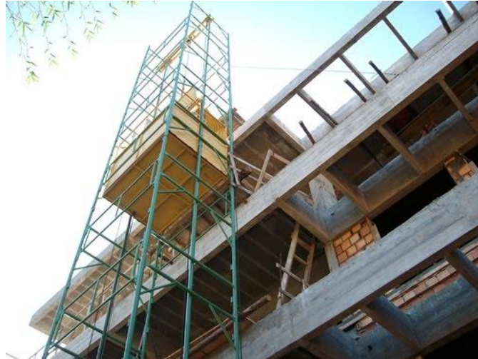
Exemplo 8 (figura 16) – Vigas projetadas da fachada
