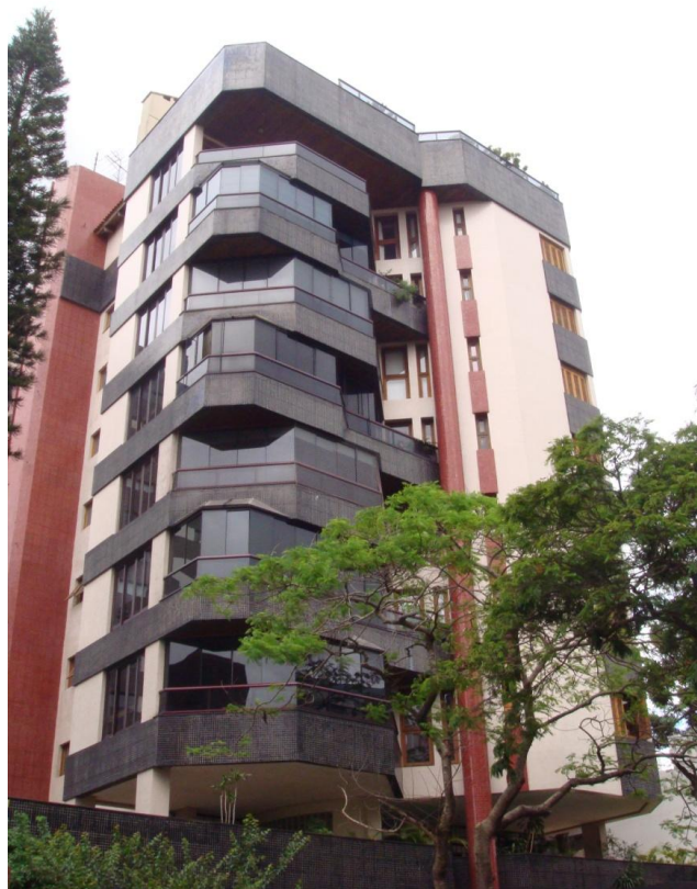
Exemplo 5 (figura 13) – Edifício com fachada angulada e recortada
