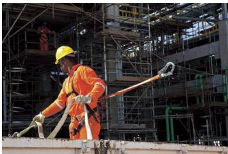
Figura 5 - Cinturão de segurança, dispositivo trava-queda e talabarte de segurança.
