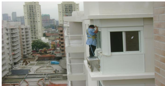
Exemplo 7 (figura 15) – Laje projetada servindo de apoio.
