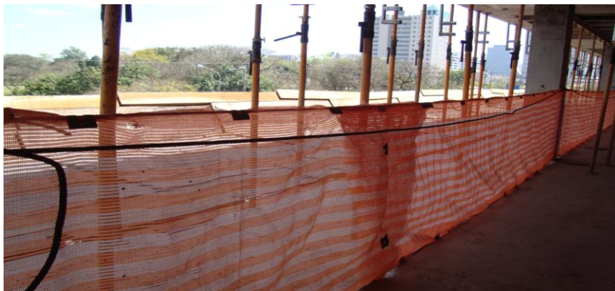
Figura 2 - Guarda-corpo tipo flexível.
