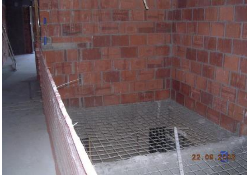
Exemplo 3 (figura 11) - Malha de ferro nos vãos dos elevadores.
