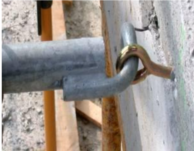
Figura 8 - Exemplo de sistema de ancoragem de andaime previamente instalado.
