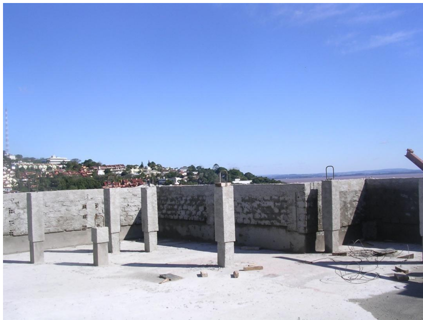
Exemplo 1 (figura 9) - Esperas para ancoragem de andaimes suspensos.
