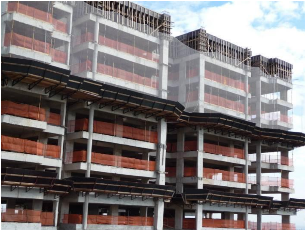
Figura 3 - Plataformas secundárias de proteção.
