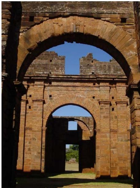
Figura 25: em primeiro plano se vê o arco original em pedra com parede de tijolos sobre ele, em segundo plano arco refeito em tijolos (foto do autor, 1991)
