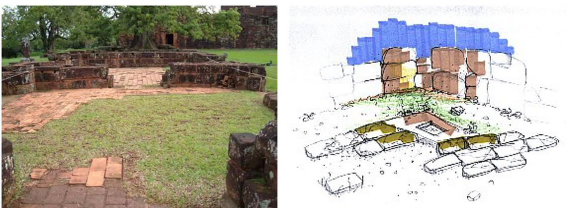
Figura 28: Pisos cerâmicos na Casa dos Padres após o processo de consolidação e levantamento gráfico, Sítio de São Miguel Arcanjo (Matilde Villegas J., 2003)
