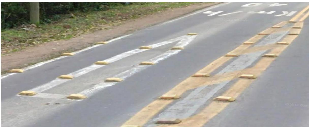
**Figura 1: MCRV do Tipo "Lápiz" Instalado**
