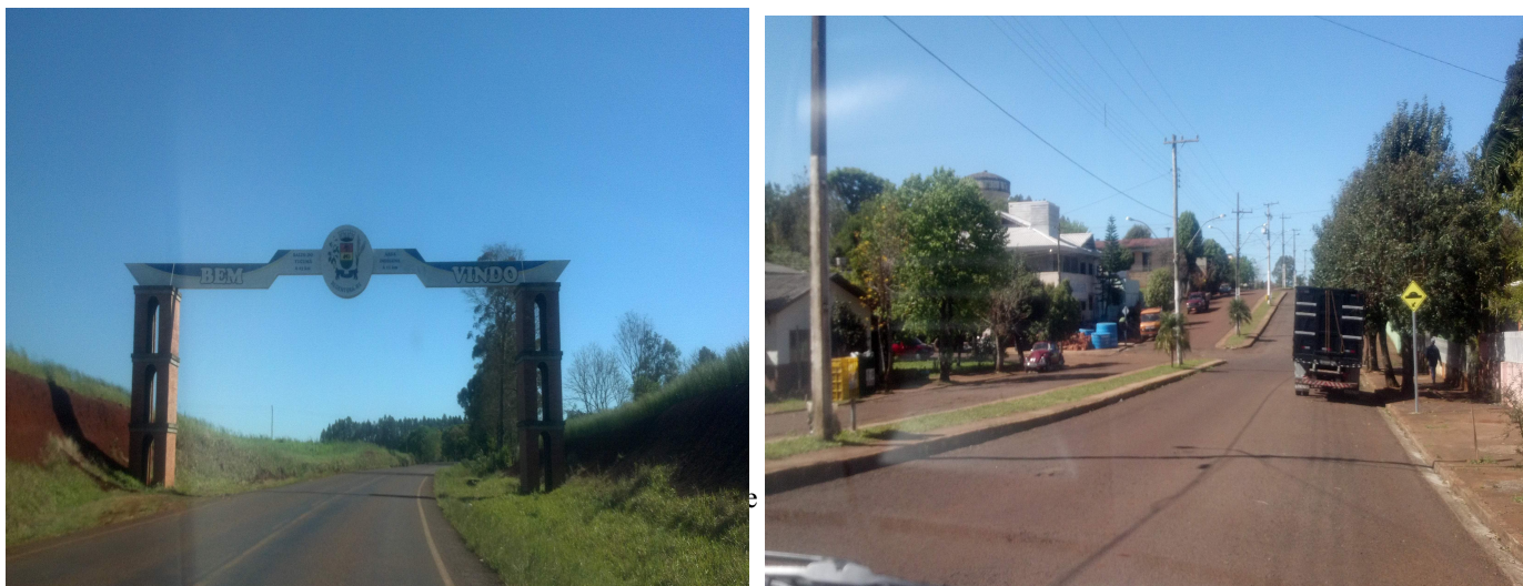
Figura 19 – Pórtico do Município de Redentora e Avenida Pres. Castelo Branco 65
