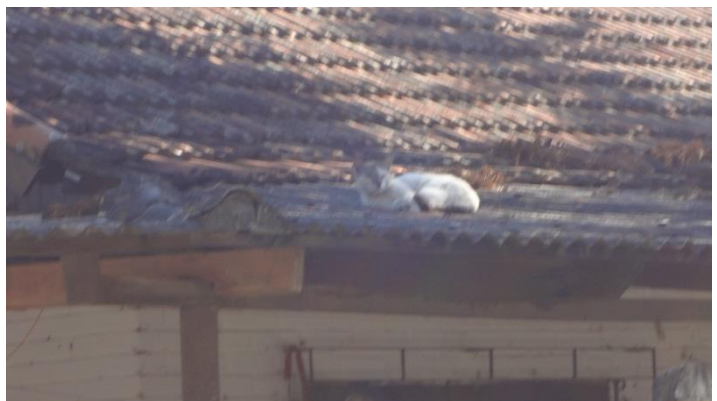
Figura 28. Gato no telhado.
