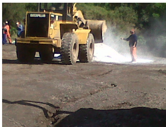
Figura 23: Processo de mistura do fíler natural com a Cal Hidratada
