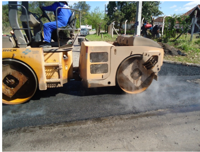
Figura 31: Processo de compactação da mistura
