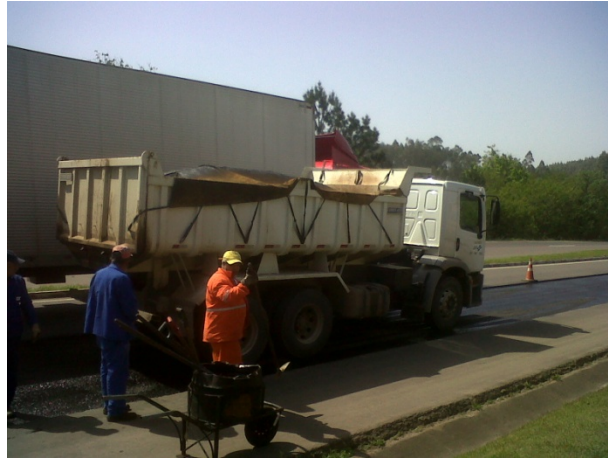
Figura 35: Lançamento da mistura SMA no trecho experimental
