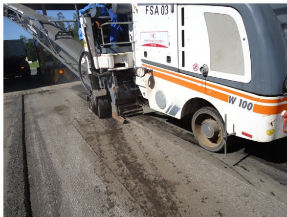
Figura 30: Correção dos defeitos de fresagem
