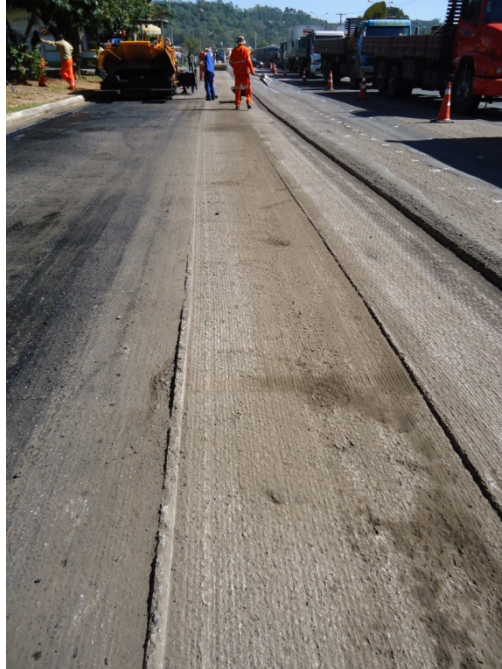
Figura 29: Fresagem da pista teste – Praça de Pedágio
