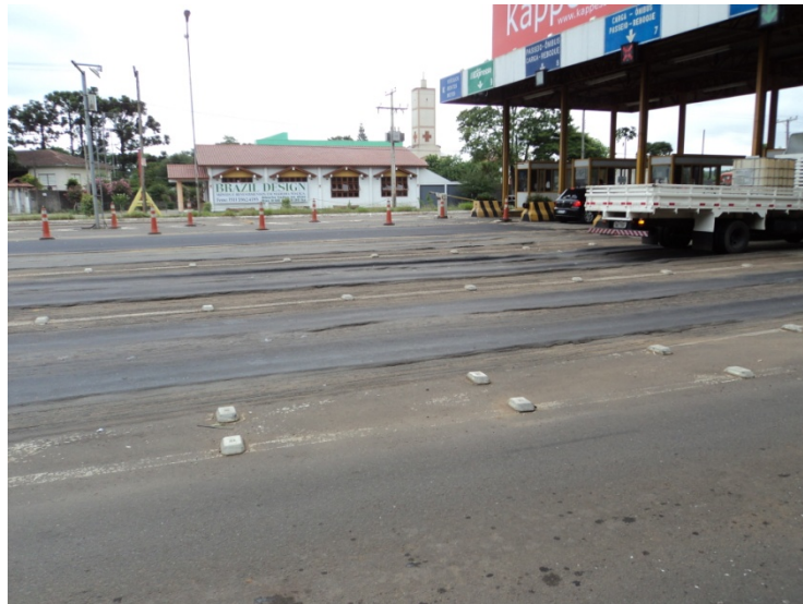
Figura 22: Deformação plástica no pavimento da Praça de Pedágio de Portão/RS
