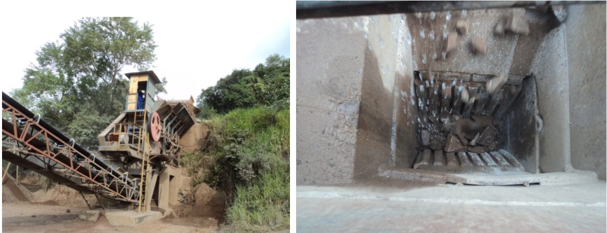
Figura 12: Britador primário Jawmaster 907HD instalado na unidade produtiva da empreiteira
