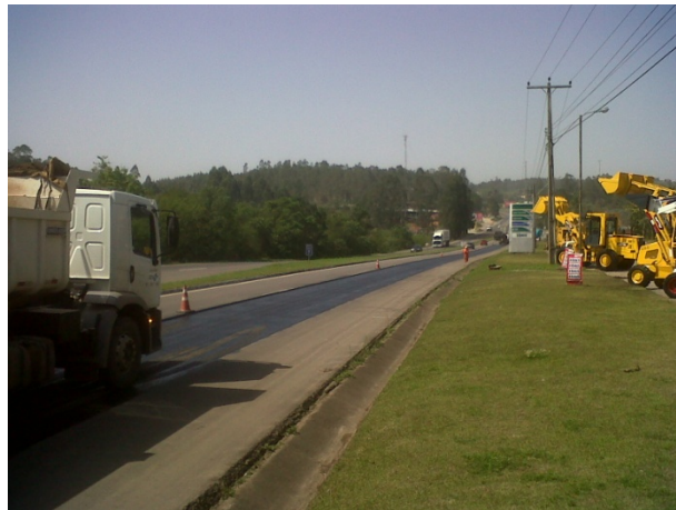
Figura 36: Trecho experimental liberado para aplicação da mistura tipo SMA
