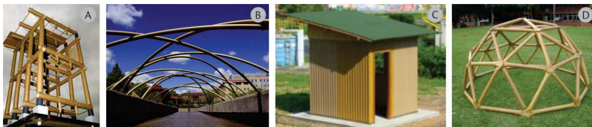
Figura 26 - Construções com tubos de papelão. (A) Sistema construtivo modular da arquiteta Mirian Vaccari. Fonte: Vaccari (2003, p. 13); (B) Portais com tubos de papelão arqueados. Fonte: Preston e Bank (2011, p. 665); (C) Célula teste de Gerusa Salado. Fonte: Salado (2011, p. 115); (D) Estrutura geodésica construída durante oficina. Fonte Laverde e Salado (2012, p. 8).
