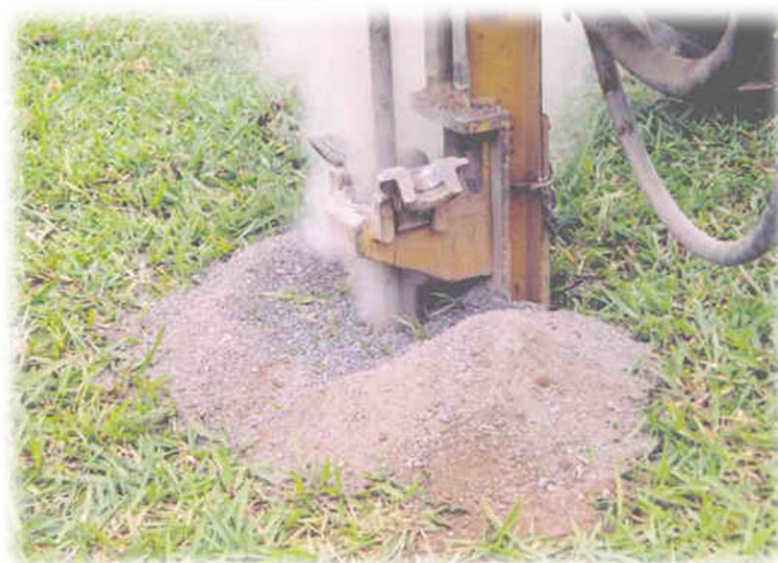
Figura 20 – Pó de rocha basáltica gerada pela perfuratriz roto-percussiva
