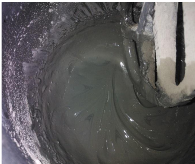
Figura 23 – Mistura da pasta de cimento na argamassadeira
