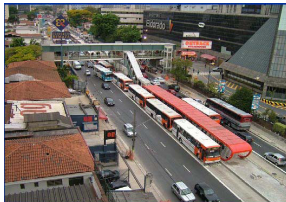
Figura 10– Congestionamento causado pela falta de faixas de ultrapassagem
