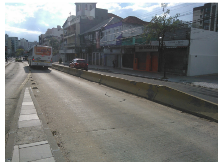
Figura 16 – Utilização de barreiras de concreto
