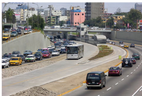
Figura 13 – Utilização de pavimentação de concreto
