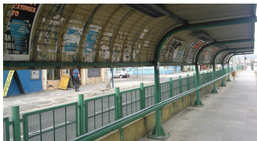
Figura 24 – Estações do corredor Bento Gonçalves
