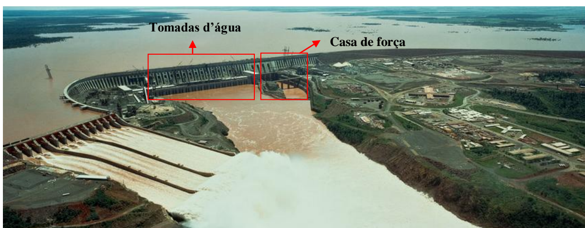
Figura 4 – Vista geral da usina hidrelétrica de Itaipu
