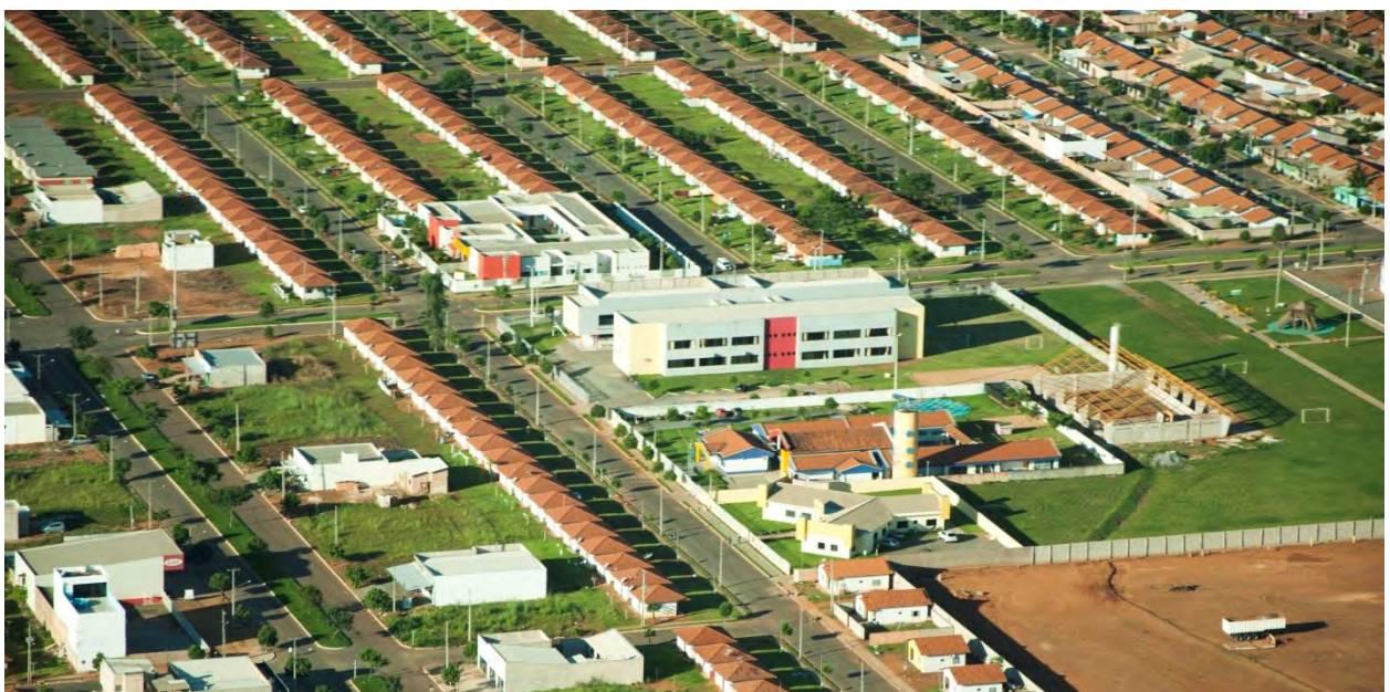
Bairro Tessele Júnior, implantado à alguns anos com os mesmos padrões utilizados no bairro Jaime Seiti Fujii A esquerda, uma das avenidas principais do bairro, que é destinada ao comércio e serviços locais; no centro estão as áreas públicas e institucionais, com praça, escola, creche e posto de saúde familiar; nas demais vias a habitação de interesse social.
