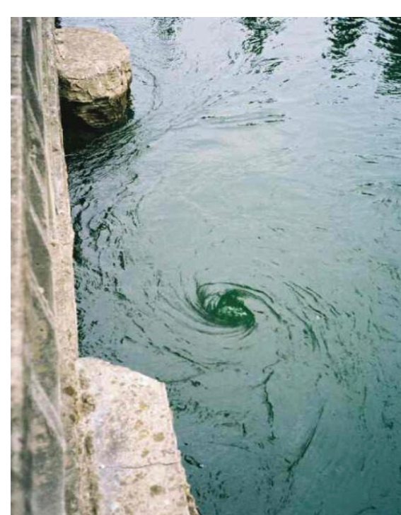
Vórtice em tomada d'água
