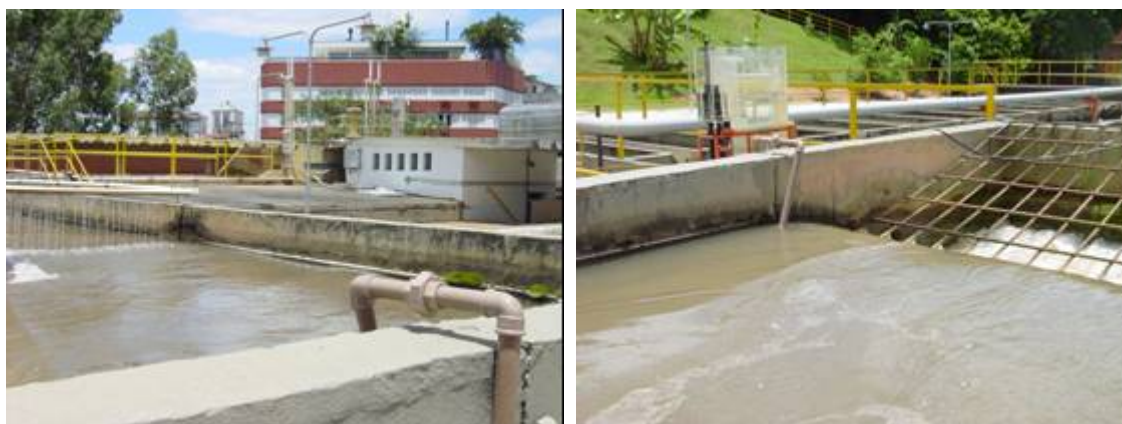
Figura 28. Captação da água bruta para clarificação no sistema RGF-F.
