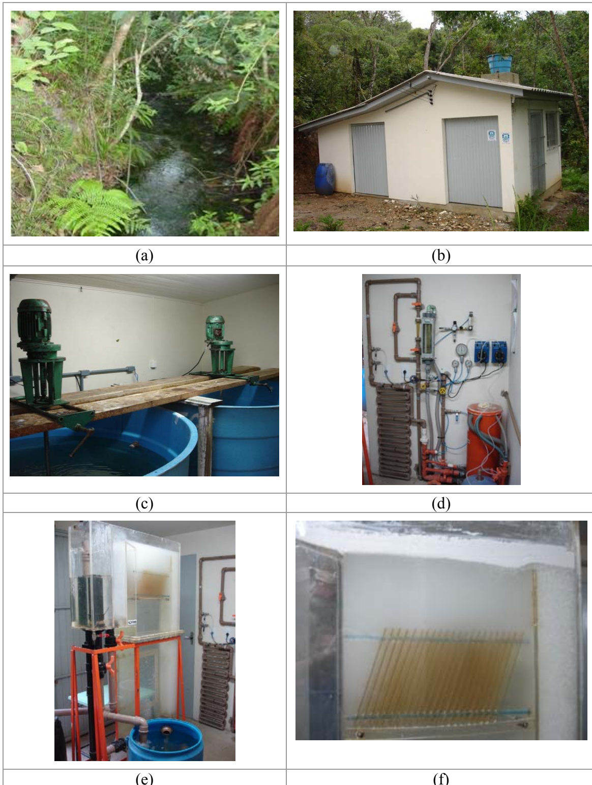
Figura 37. Fluxo da DAM da mina de carvão extinta (SS-16) – Criciúma/SC (a); Estação Piloto de Tratamento da DAM construída próxima a área atingida (b); Tanques de neutralização/precipitação dos íons metálicos e íons sulfato (c); Sistema de agregação em linha, constituído por uma serpentina (S) e o RGF-F (d); Sistema piloto de flotação por ar dissolvido de alta taxa (e); Detalhe da camada de lodo de etringita separado no processo de flotação (f).
