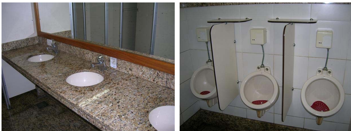
Figura 3: banheiro de alunos da Escola de Administração
