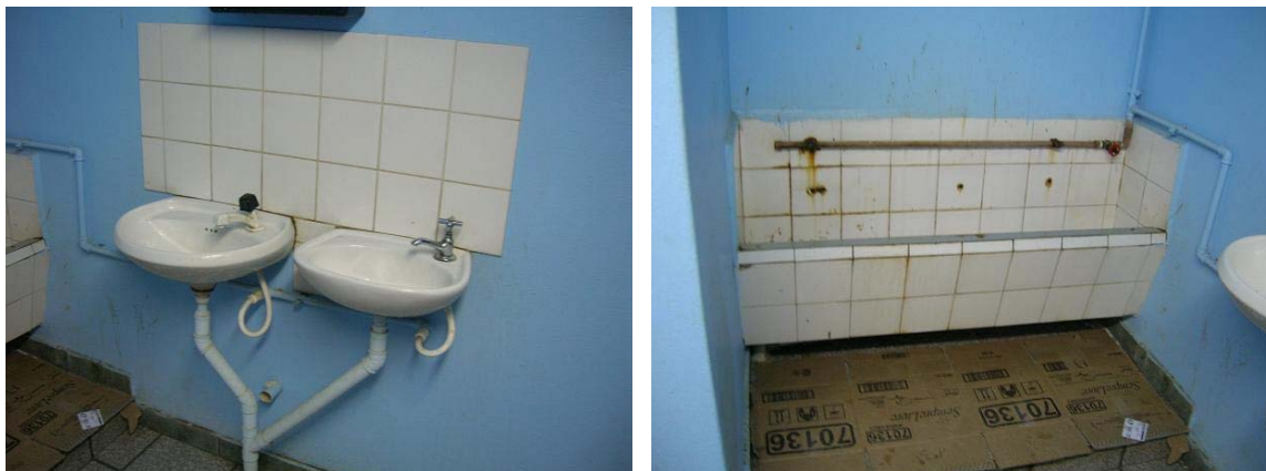
Figura 5: banheiro de funcionários da Prefeitura do Campus do Vale
