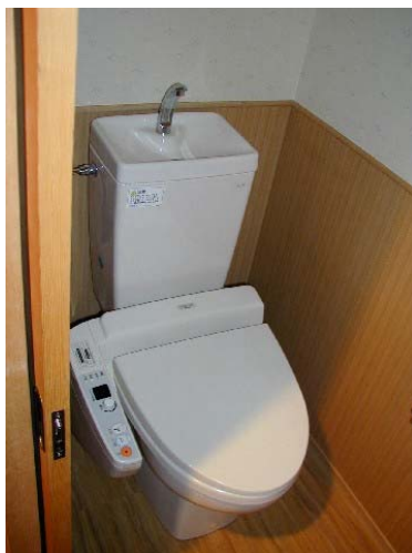
Figura 15: bacia sanitária com lavatório
