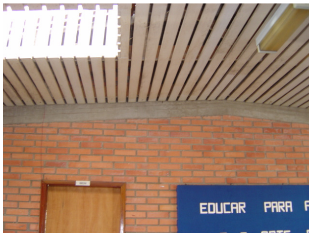
Figura 42: forro de madeira das áreas de circulação da Escola Carlos Barbosa Gonçalves.
