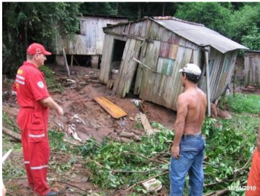
Figura 19: Imagem do local após o deslizamento, ponto 007.
