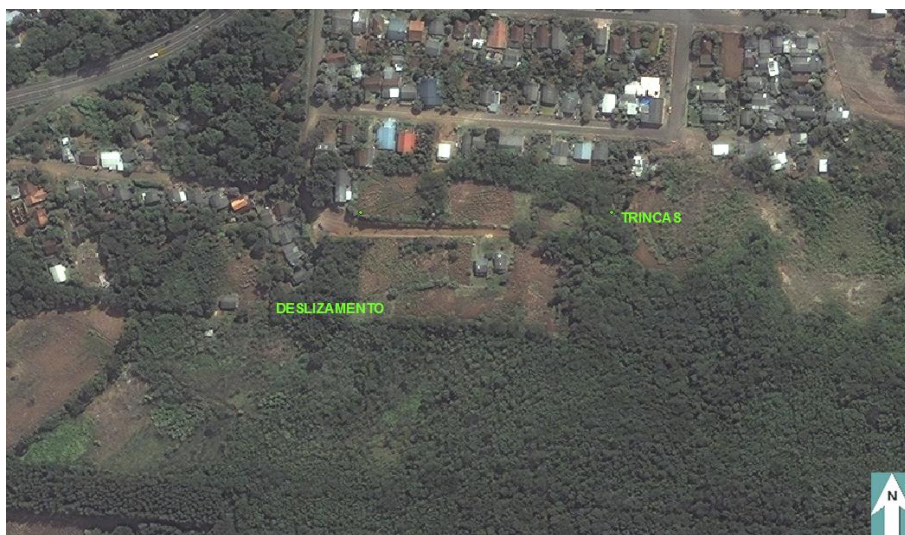
Figura 50: Eventos de deslizamento ocorridos na zona 5.
