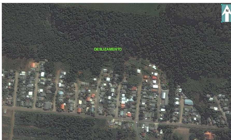
Figura 51: Imagem mostrando o local de deslizamento.
