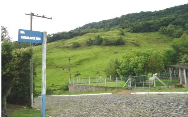
Figura 41: Movimento de rastejo no Bairro Viaduto.
