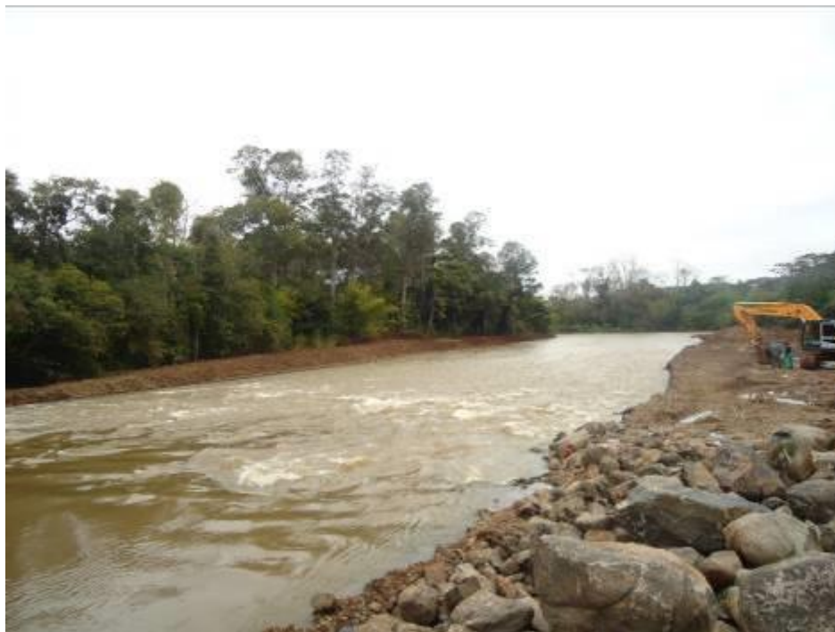
Figura 17: Apresentação do Rio Paranhana, onde está sendo realizada a recuperação das suas margens, ponto 006.
