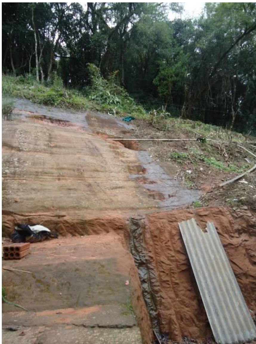
Figura 25: Deslizamento ocorrido no Bairro Figueira (ponto 009).
