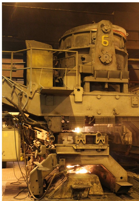
Figura 2.8 Panela realizando a passagem de aço líquido para o distribuidor, que faz o mesmo para os veios da máquina de lingotamento contínuo Fonte: Cortesia de usina siderúrgica.
