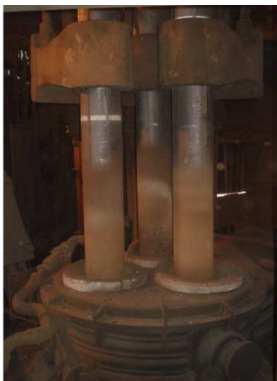
Figura 2.7 Forno-panela em funcionamento Fonte: Cortesia de usina siderúrgica.
