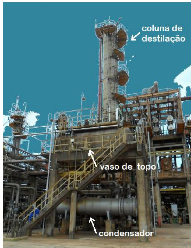
Figura 2-2 Disposição dos equipamentos num sistema de hot-bypass (Fonte: adaptado de Fydryzewski, 2011)
