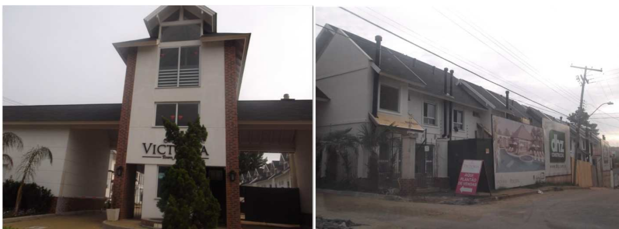
Figuras 22 e 23 – Condomínio Condado, Victória Town House . Fonte: Alexandre Rosa, maio 2013.
