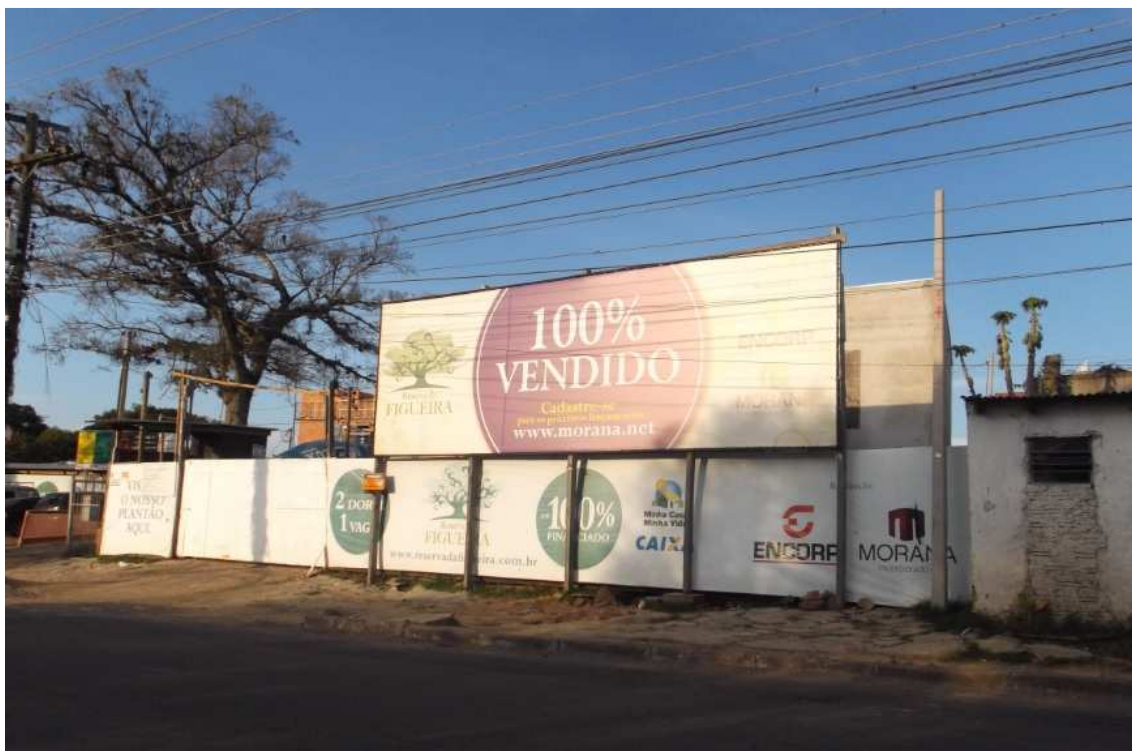
Figura 37: Área onde está sendo construído o Reserva da Figueira. Localizado na Parada 13 Fonte: Alexandre Rosa, agosto 2013.
