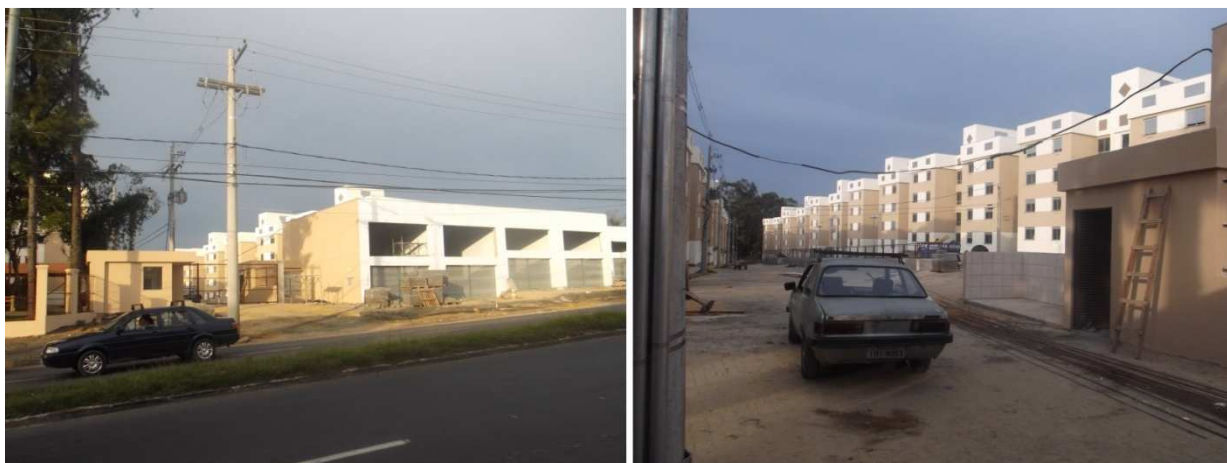
Figuras 29 e 30: Condomínio Alto do Bosque, ainda semiacabado. Localizado na Parada 3. Fonte: O autor, maio 2013.
