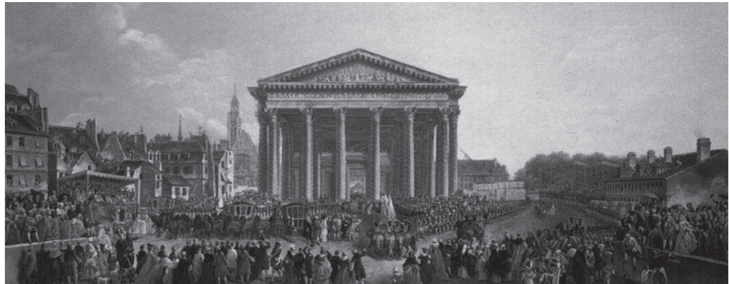
FIGURA 1 | O início das obras da igreja de Sainte-Geneviève, Paris, 1765. Pierre-Antoine de Machy, pintor. Coleção do Museu Carnavalet, Paris, França.
