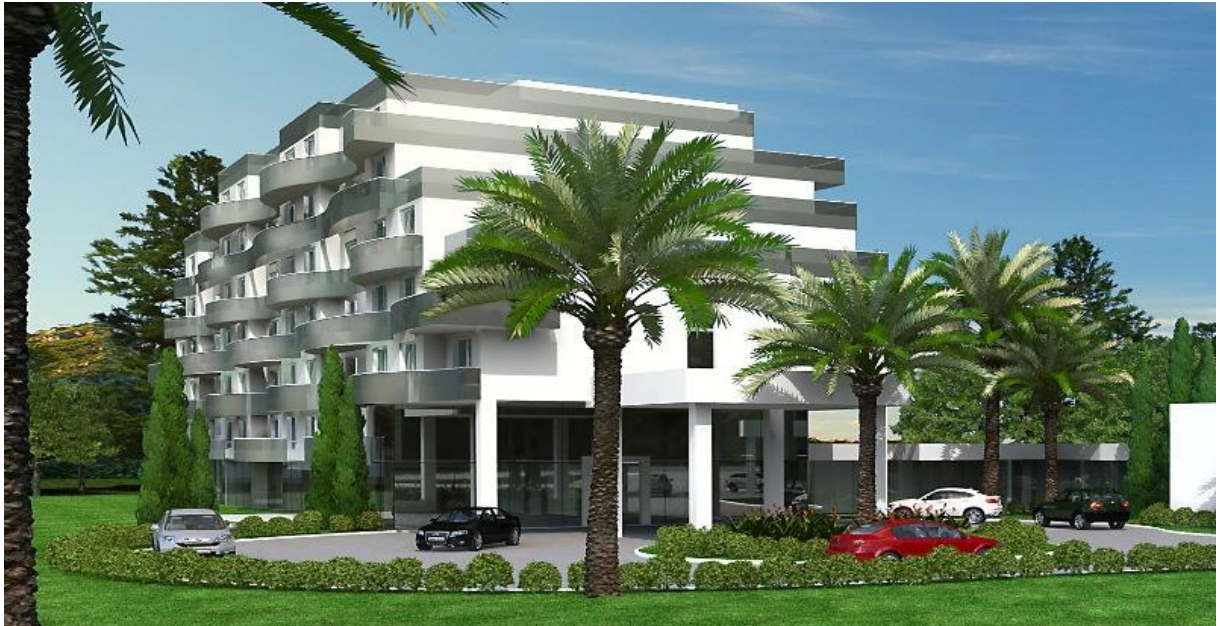
Figura 3: Fachada do hotel
