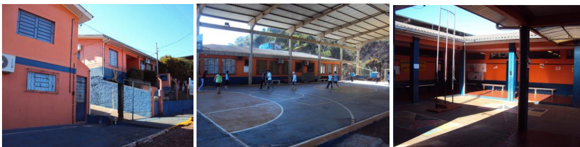
Figura 1 – Escola Municipal de Ensino Fundamental Antonio Zambrzycki
