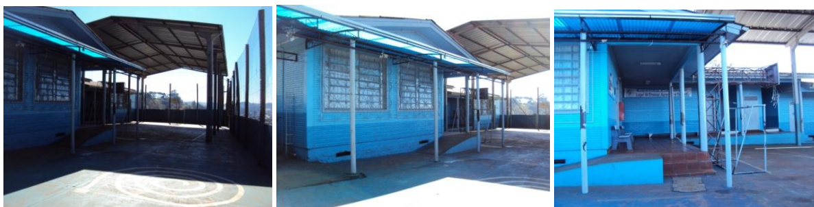
Figura 3 – Escola Municipal de Ensino Fundamental Cônego Stanislau Olejnik
