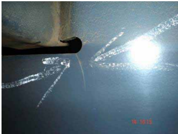
Figura 5.10 – Trincas ocorridas em serviço na alma da longarina (ponto 1).
