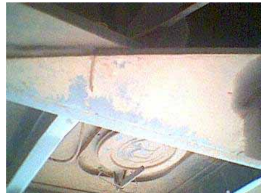
Figura 5.11 – Trincas ocorridas em serviço no reforço da aba inferior da longarina (ponto 2).
