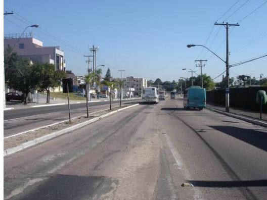
Figura 10 Avenida Bento Gonçalves
