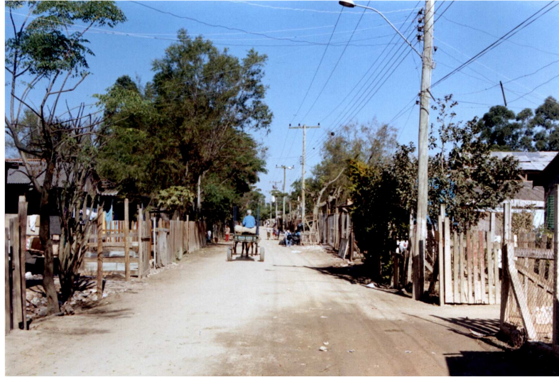
Figura 7: vista da Rua Nossa Senhora Aparecida - vila
