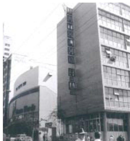
Fig. 8 Edifício Autolon e Cine Ouro Verde Villanova Artigas . Londrina . PR
