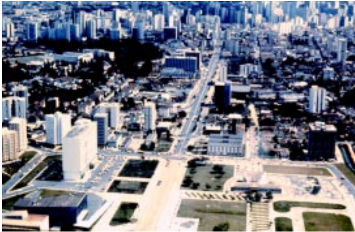
Fig. 108 Vista aérea com o Plenário da Assembleia Legislativa, o edifício para as Secretarias de Estado (com 12 pavimentos) e o Tribunal do Júri
