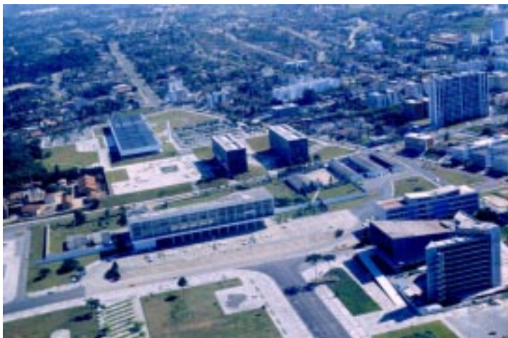
Fig. 109 Vista aérea com a inserção do Anexo da Assembleia Legislativa, os dois blocos para as Secretarias de Estado, posteriormente ao Palácio do Governo, e o bloco principal do Instituto de Educação.
