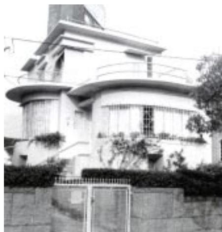
Fig. 4 Residência Bernardo Kirchgässner . 1936 Curitiba . PR
