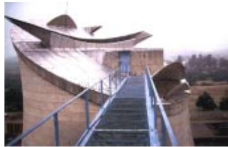
Fig. 97 Chandigarh . Torre de resfriamento
