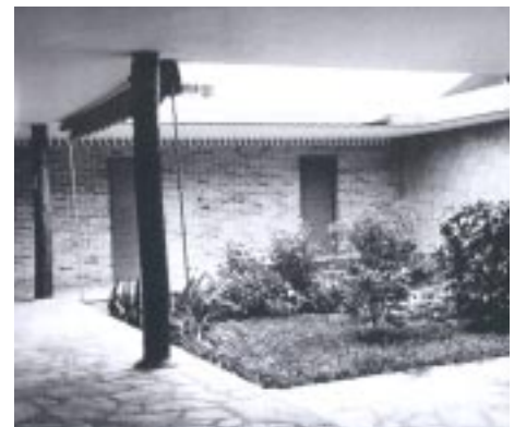
Fig. 13 Casa Giocondo Vilanova Artigas . Vilanova Artigas . Caiobá . PR
