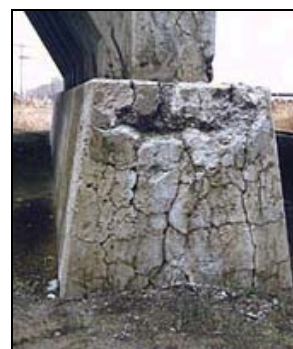
d) Fissuração em pé de pilar da estrutura de um viaduto na China
