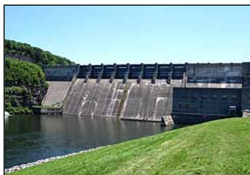
b) Fissuração e exudação de gel em barragem nos Estados Unidos
