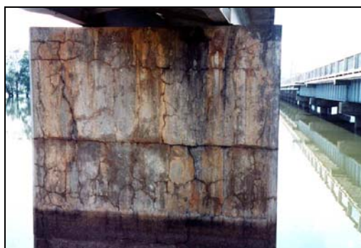
c) Fissuração mapeada da estrutura de uma ponte na Austrália
