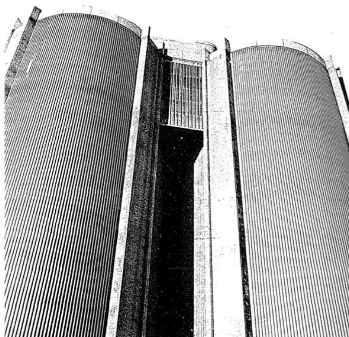
Figura 2 – Silo com parede circular de concreto protendido
