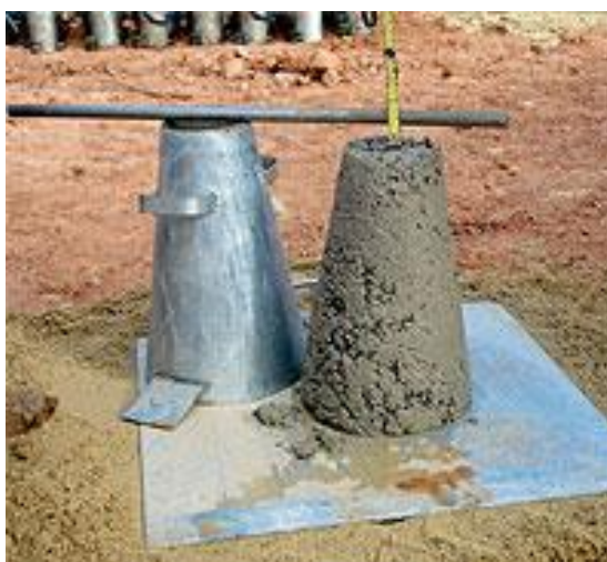
Figura 3 – Ensaio de abatimento de tronco de cone realizado em obra
