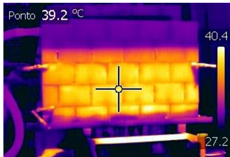
Figura 26 – Análise termográfica da parede após 5 horas de ensaio (câmara)
