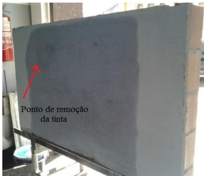
Figura 27 – Análise da mancha na face da parede em contato com a câmara
