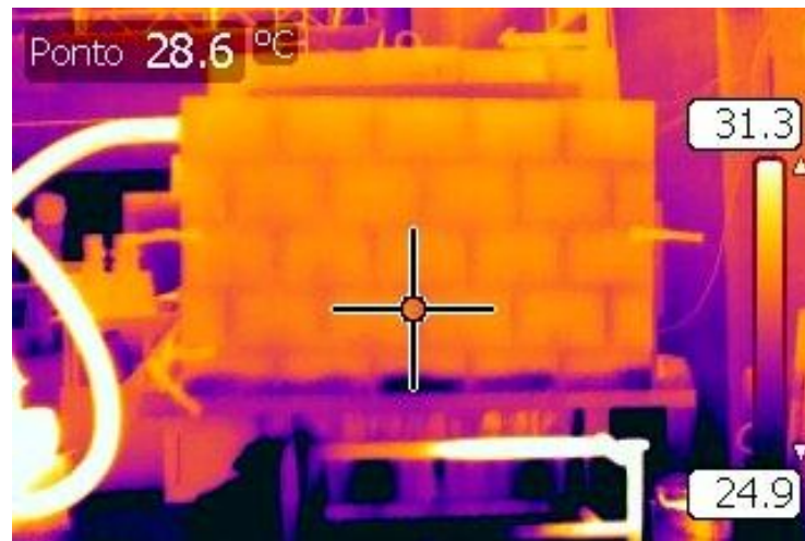
Figura 25 – Análise termográfica da parede durante o ensaio da câmara
