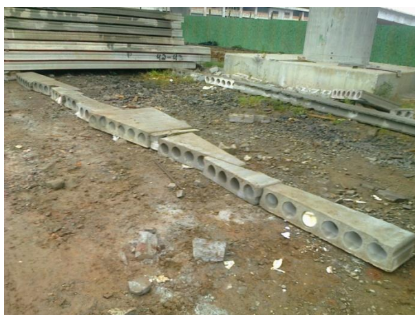
Figura 32 – Resíduos de corte de lajes
