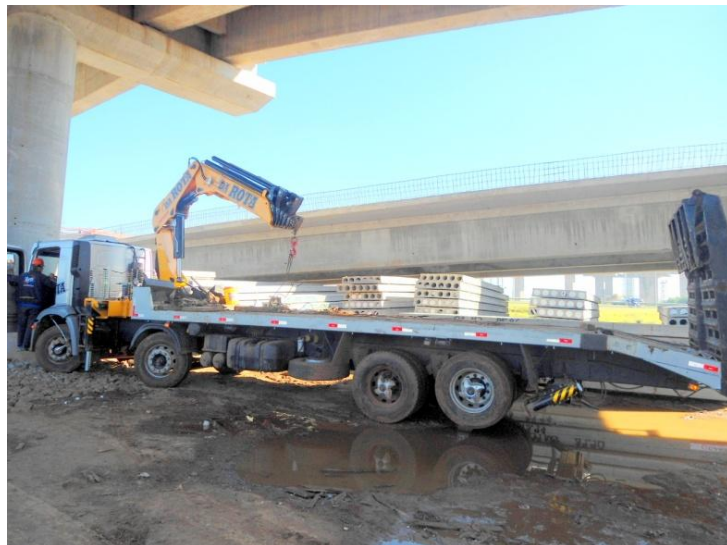
Figura 50 – Carregamento de peças via caminhão Munck
