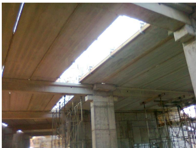
Figura 31 – Pavimento em espera para conclusão
