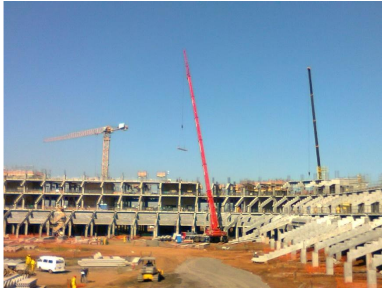
Figura 21 – Guindaste em operação (centro)
