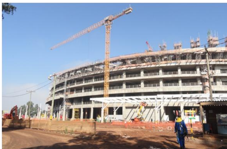
Figura 20 – Grua operando na parte externa da estrutura
