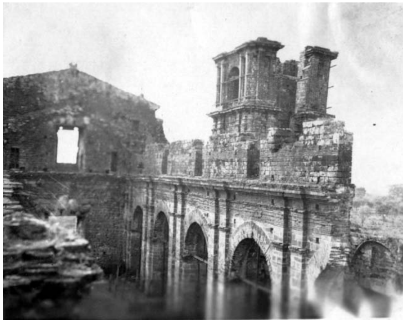
Figura 37: vista interna nave central - arcada do lado do evangelho, após colocação dos trilhos (Arquivo Noronha Santos, após 1927)
