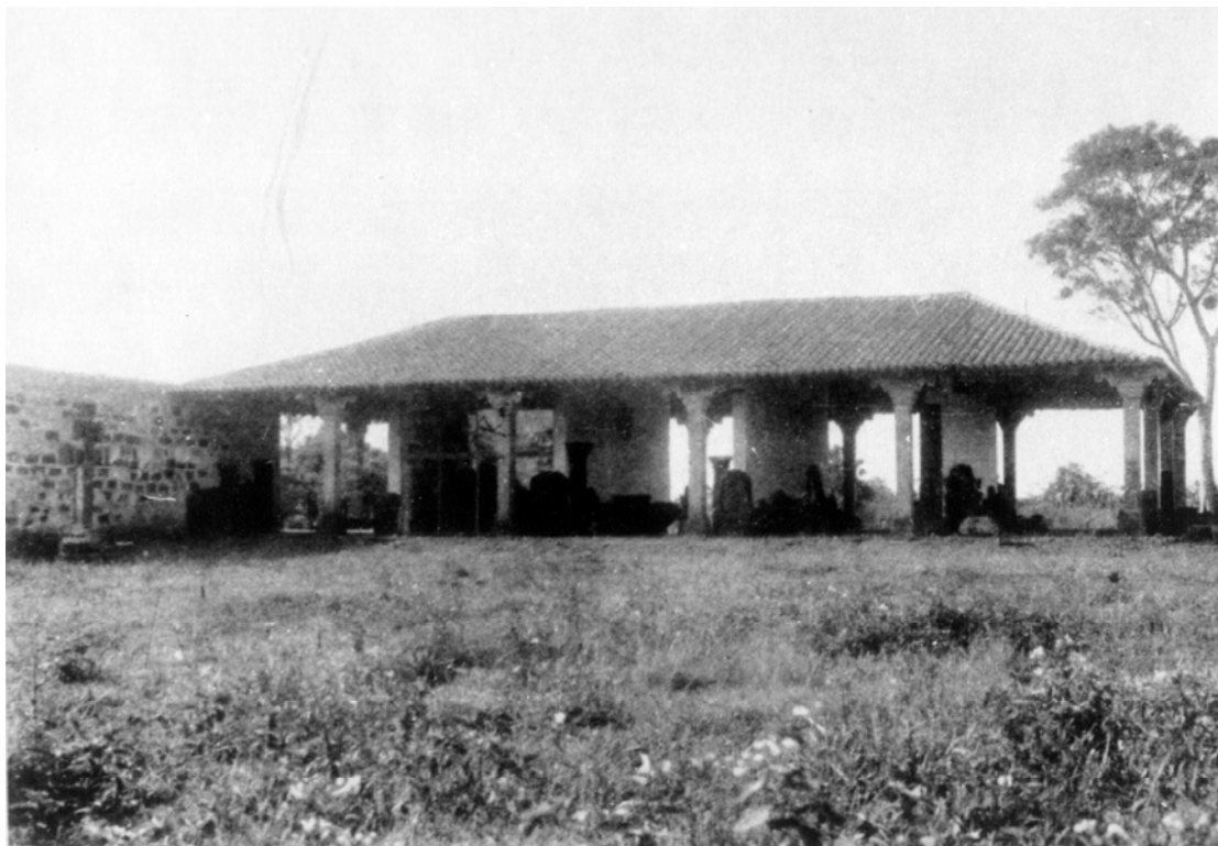
Figura 88: colocação dos vidros nas salas do Museu (Arquivo Noronha Santos, 1940).
