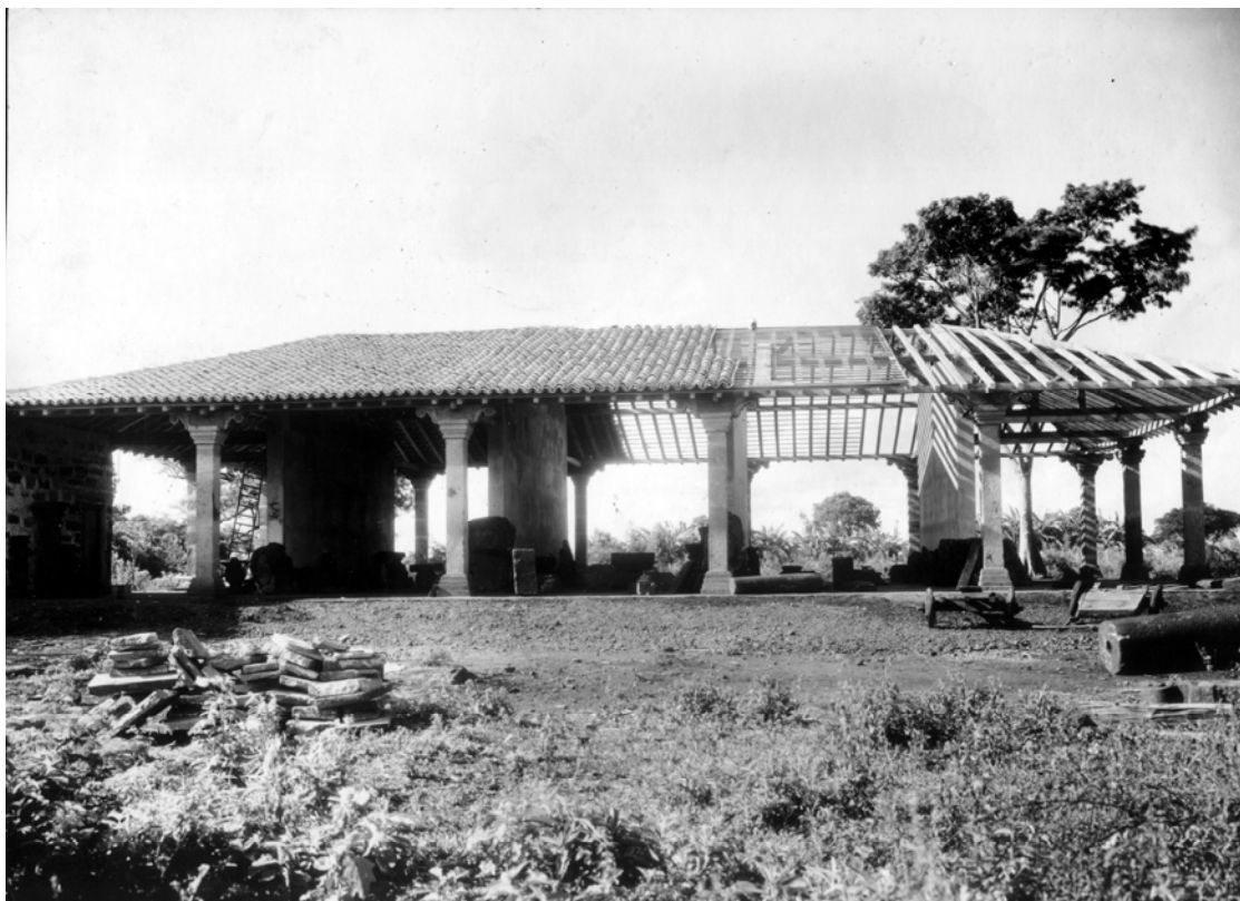
Figura 81: construção da cobertura do Museu - vista sul (Arquivo Noronha Santos, 1939)
