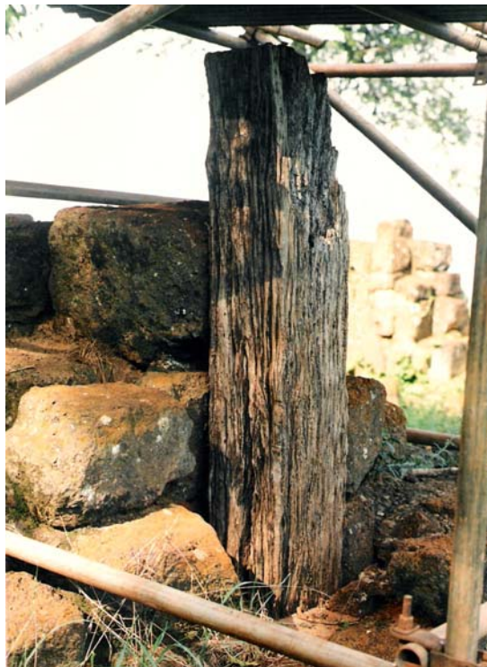
Figura 5: pilar de madeira utilizada nas estruturas autônomas
