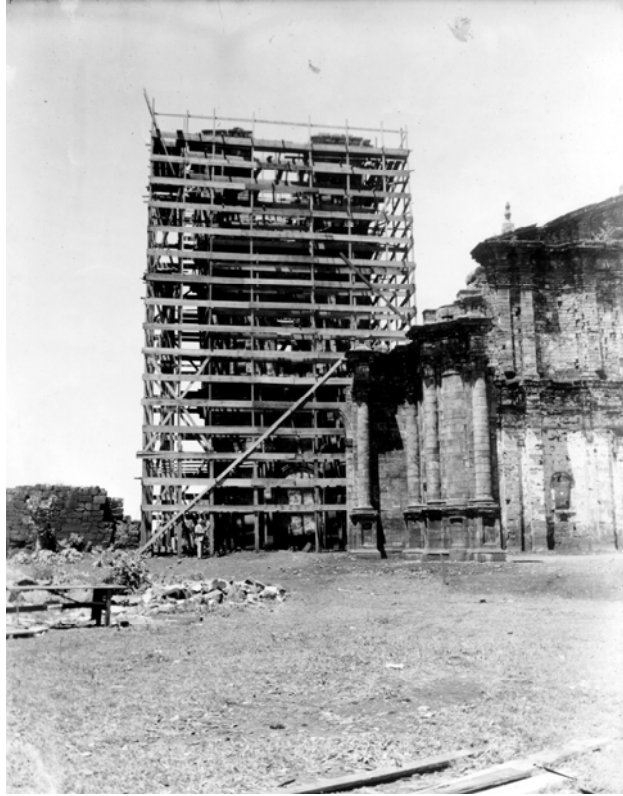
Figura 65: torre sendo desmontada (Arquivo Noronha Santos, 1938)
