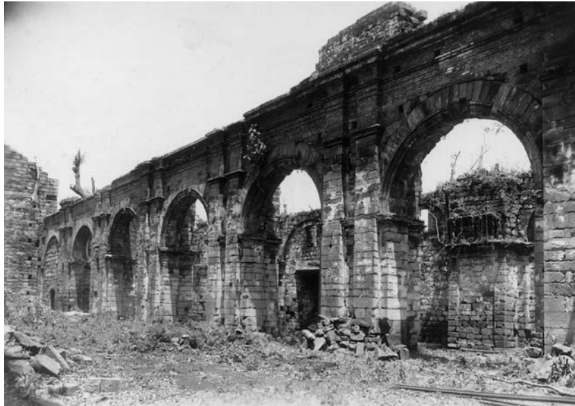
Figura 36: vista da arcada interna, lado da epístola no início das obras, os trilhos estão no chão (Arquivo Noronha Santos, anterior a 1925)
