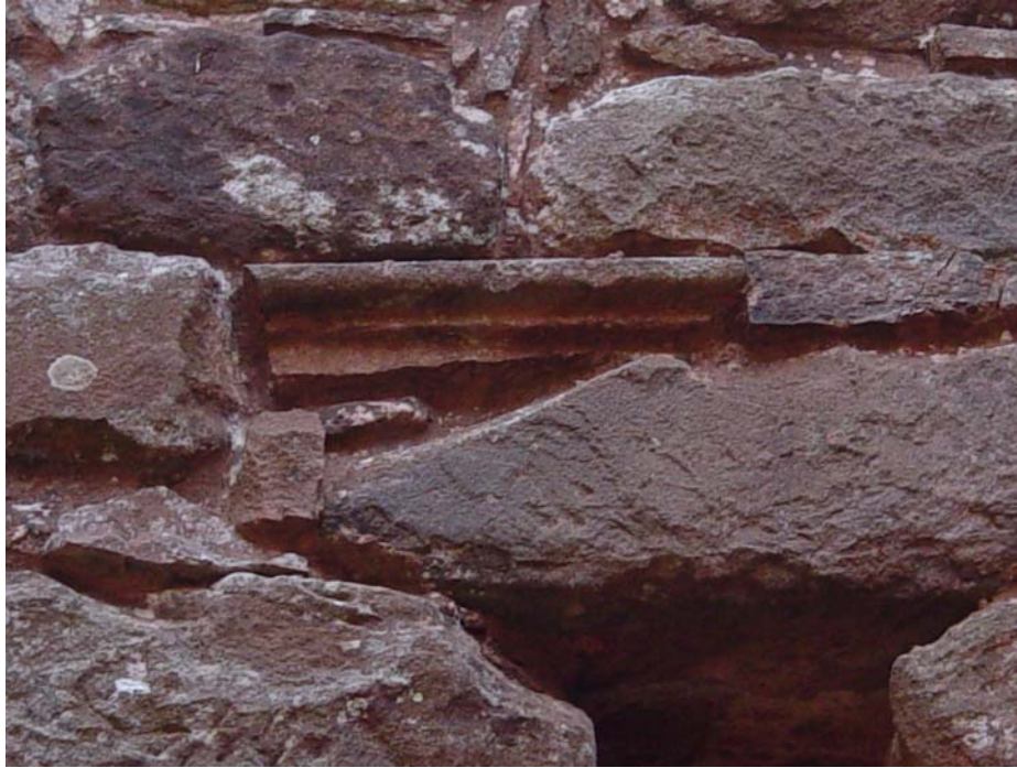
Figura 23: detalhe da parede sul sacristia nova composta com pedras não aparelhadas e fragmento de cimalha
