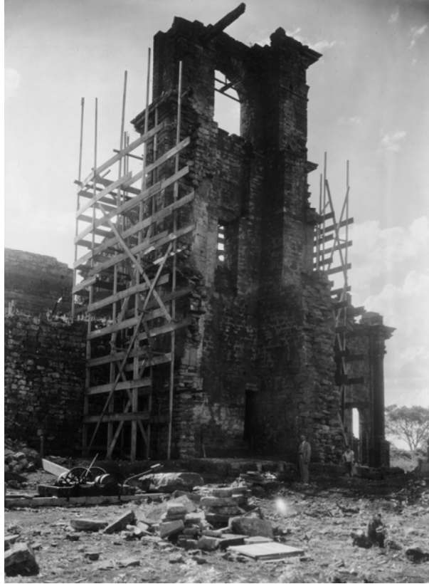
Figura 67: lateral leste da torre desmontada (Arquivo Noronha Santos, 1938)
