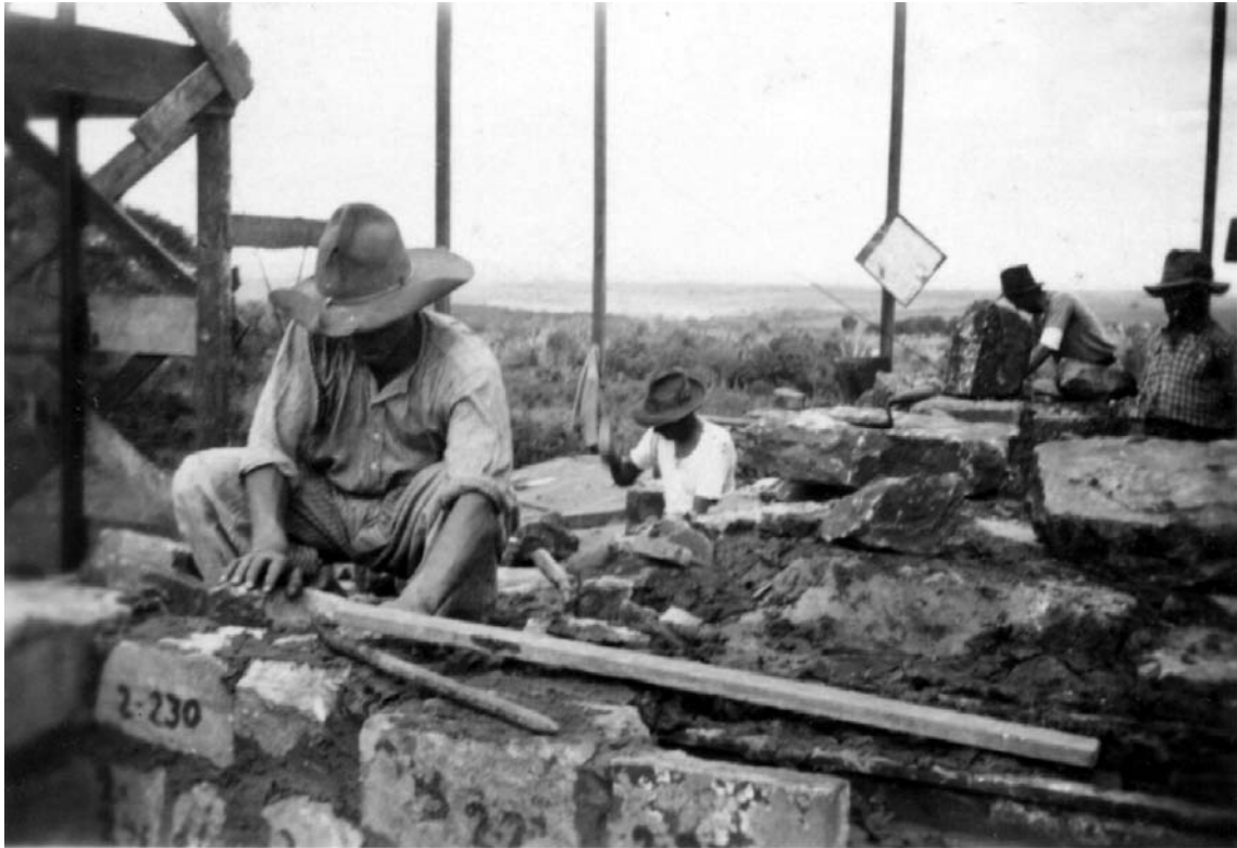
Figura 71: operários assentando pedras numeradas (Arquivo Noronha Santos, 1939)
