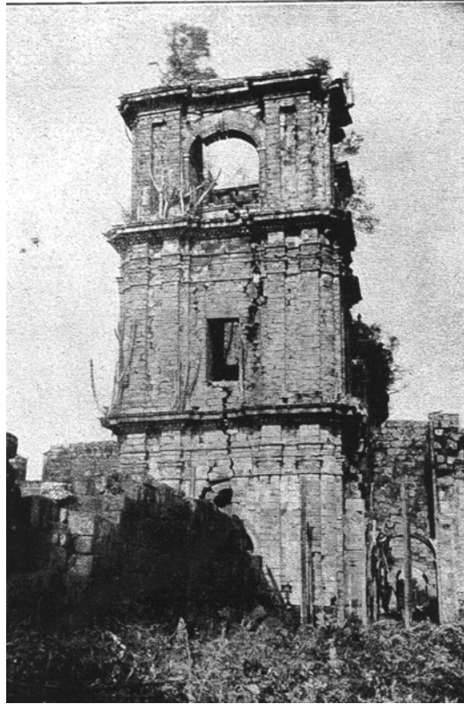
Figura 38: torre antes das obras (Diretoria de Colonização e Terras, 1925)
