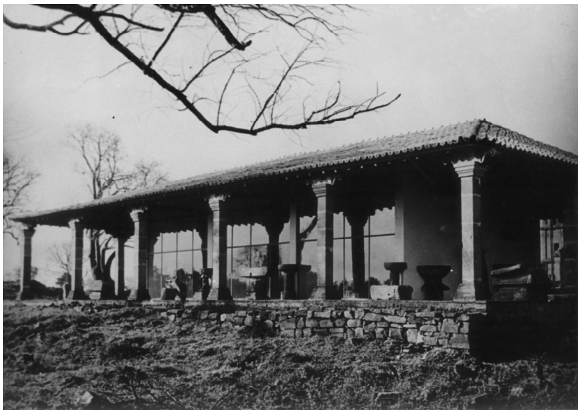
Figura 89: Museu com acervo e com os vidros colocados (Arquivo Noronha Santos, 1940)
