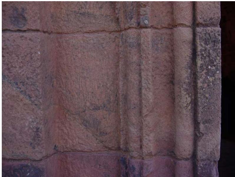
Figura 6: pedra de arenito esculpida utilizada no umbral da porta da sacristia da igreja de São Miguel
