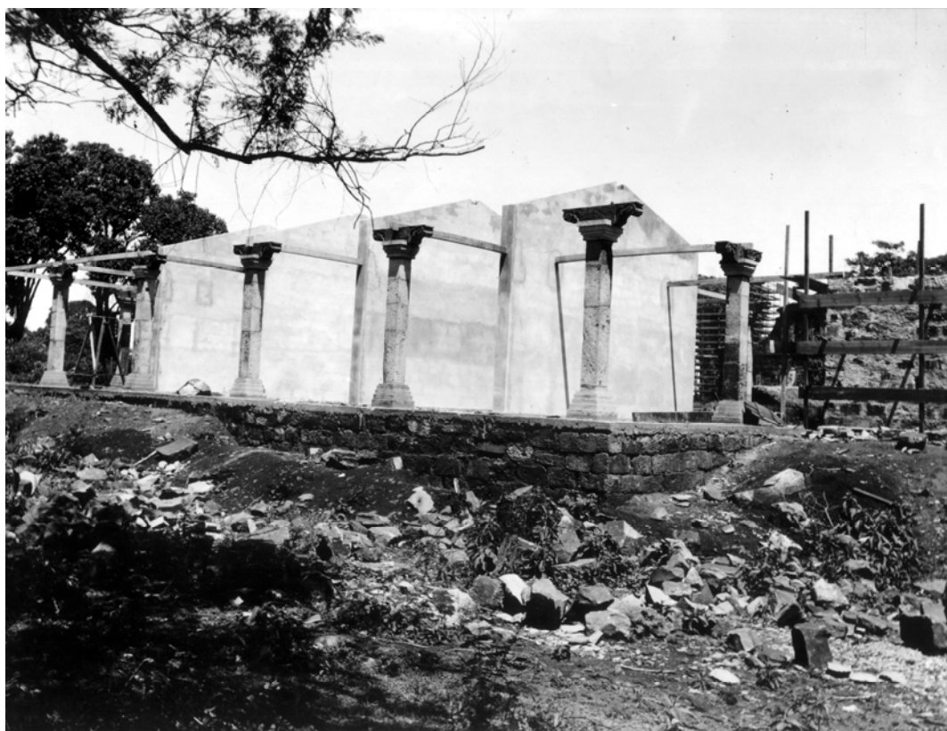
Figura 80: construção do Museu e Casa do Zelador (Arquivo Noronha Santos, 1938)
