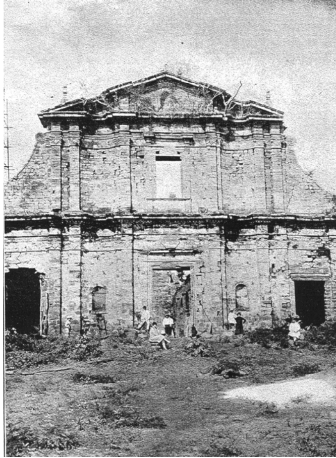
Figura 32: detalhe da fachada principal durante os trabalhos. Janela superior estabilizada. (Diretoria de Colonização e Terras, 1925)
