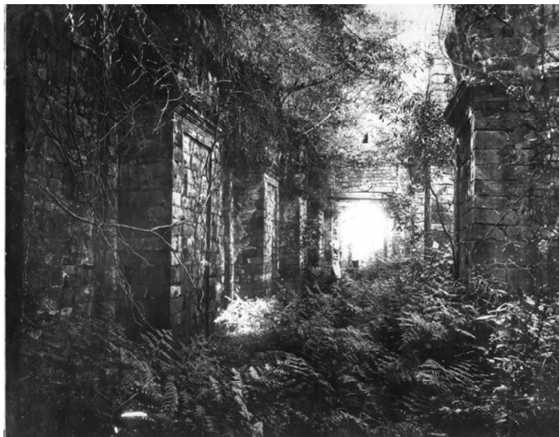
Figura 29: nave lateral, lado epístola, arruinamento antes das obras de 1925 (Arquivo Noronha Santos)
