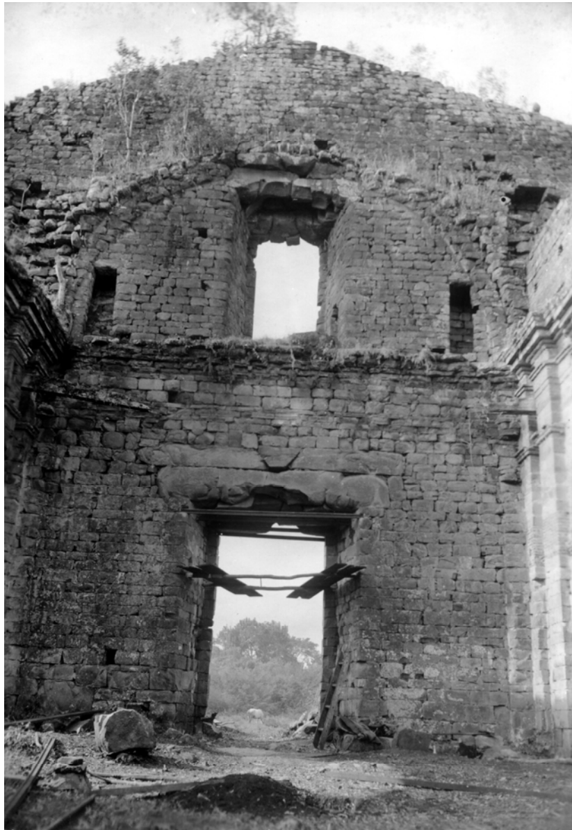
Figura 33: interior Igreja, fachada. Colocação dos trilhos [1925] (Arquivo Noronha Santos)
