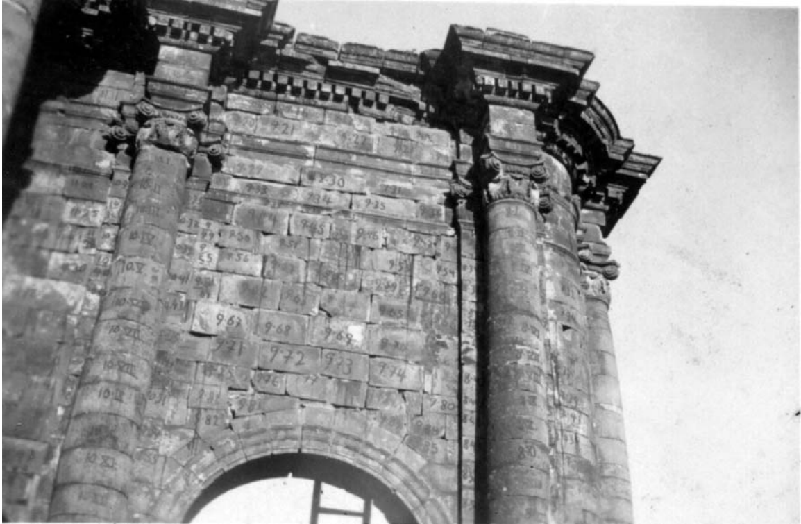
Figura 59: detalhe do acabamento do pórtico remontado com numeração das pedras (Arquivo Noronha Santos, 1938).
