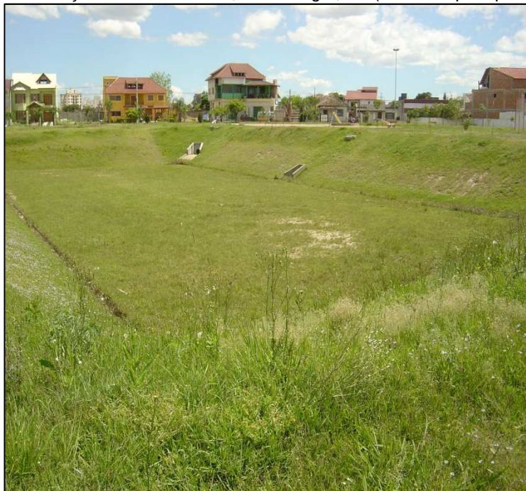
Figura 2.8: Bacia de detenção off-line – Ecoville, Porto Alegre, RS (Fonte: Arquivo pessoal)
