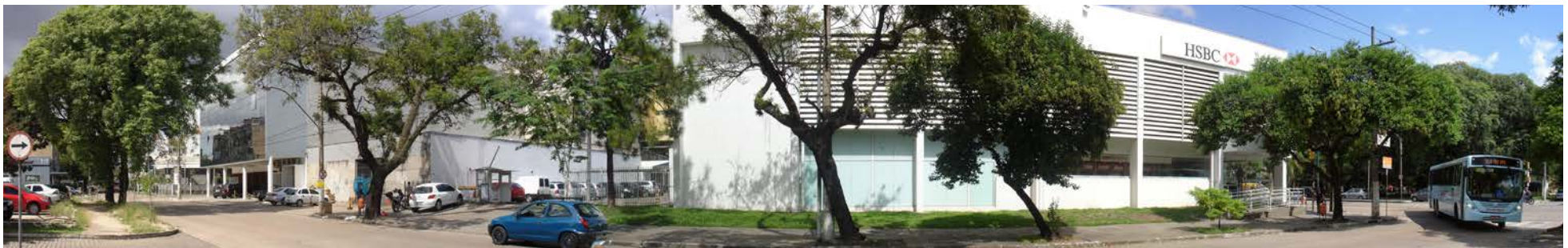
avenida brasil - vista oposta ao terreno
