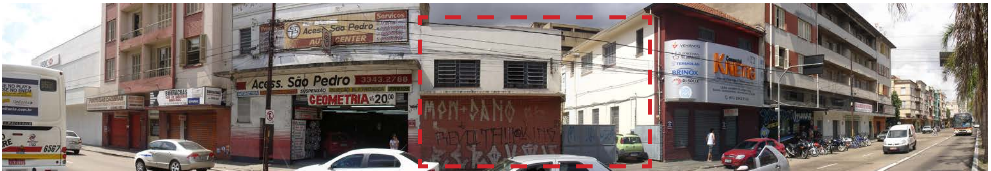
vista das edificações - em destaque edificação possível de ser desapropriada e demolida para construção do acesso à plataforma.
