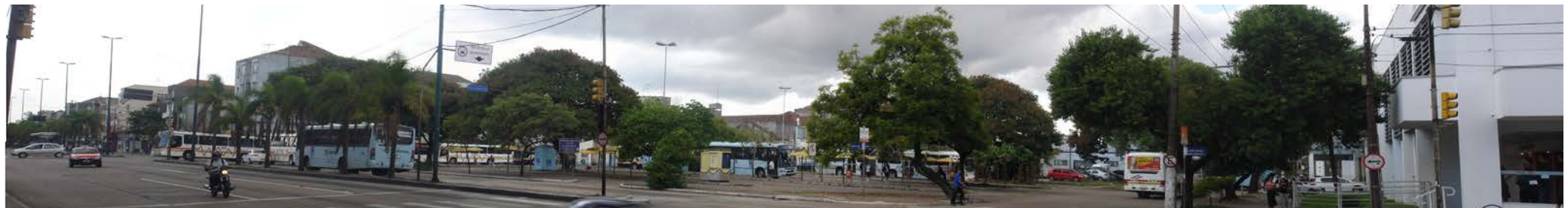
vista geral da quadra a ser utilizada para a edificação da estação de integração multimodal.
