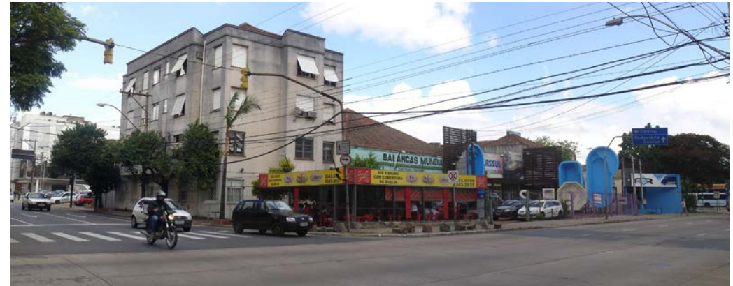
edificações existentes no terreno ( esquina av. pernambuco / avenida cairu ) que deverão ser demolidas
