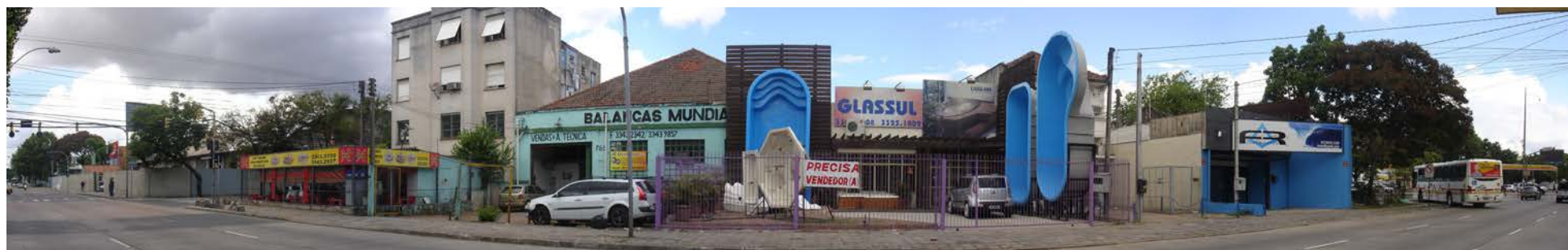
avenida cairu - vista para o terreno
