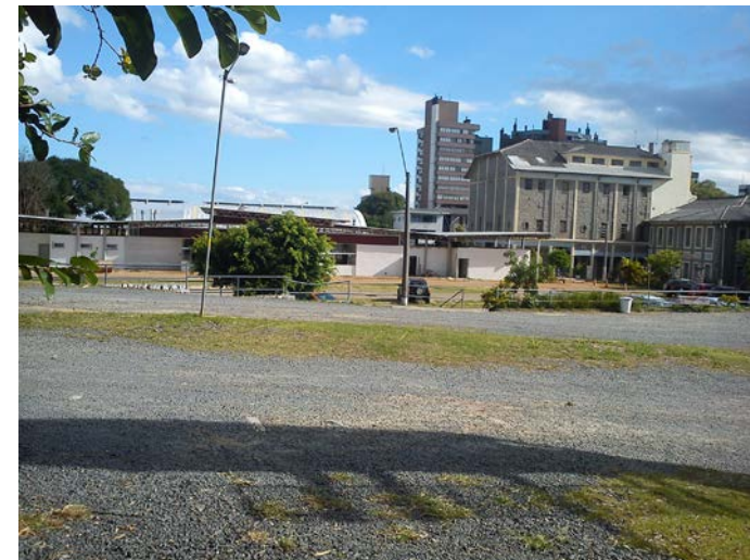
Edifício contendo restaurante e lojas visto a partir da Rua Casemiro de Abreu
