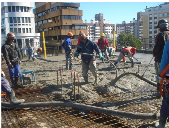
Figura 33 – Etapas de lançamento, adensamento e nivelamento
