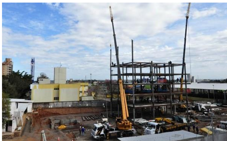
Figura 15 – Vista do canteiro de obra
