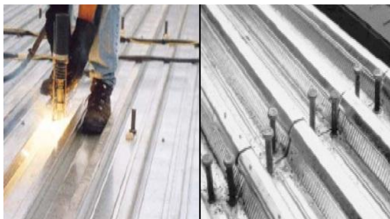
Figura 7 – Instalação stud bolt
