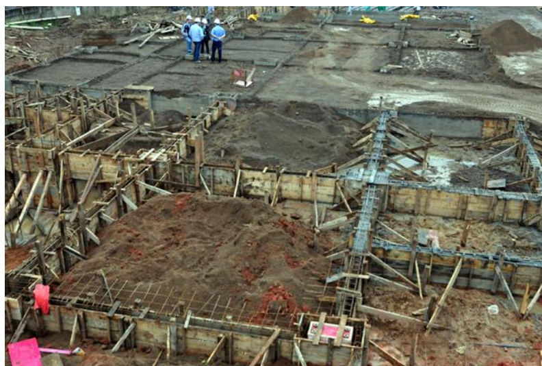
Figura 16 – Execução das fundações
