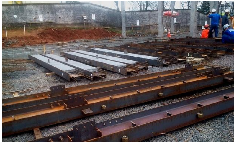
Figura 18 – Pilares mistos armazenados no canteiro
