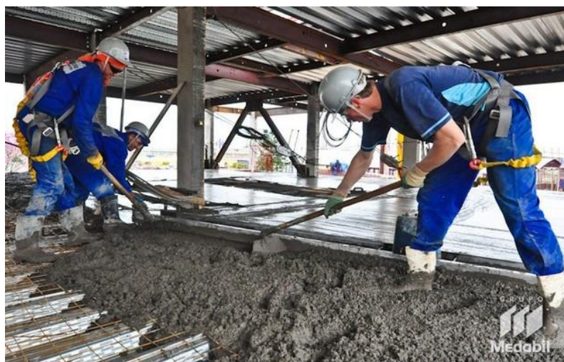
Figura 24 – Espalhamento do concreto
