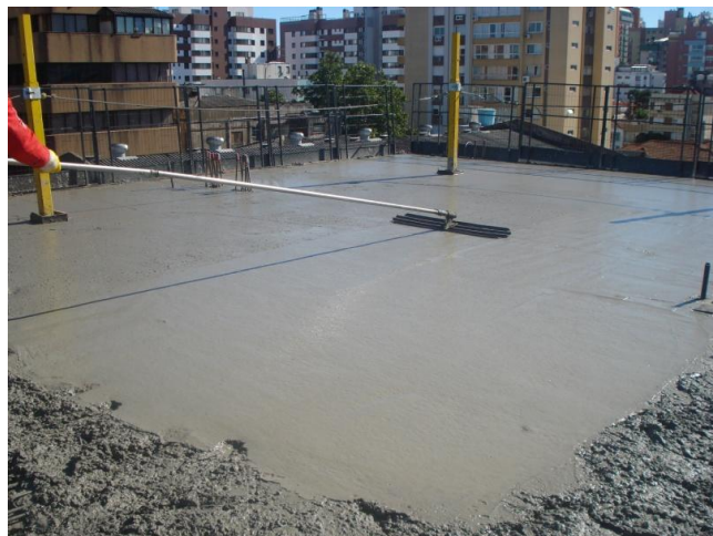
Figura 35 – Aplicação do bullfloat
