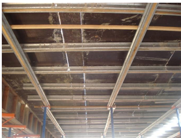
Figura 29 – Barroteamento metálico
