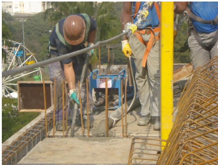
Figura 31 – Concretagem dos pilares
