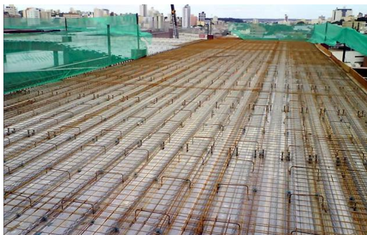
Figura 9 – Detalhe das armaduras em uma laje mista
