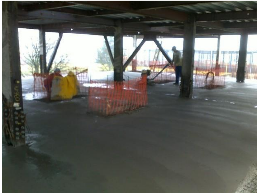
Figura 25 – Acabamento final da laje com helicóptero
