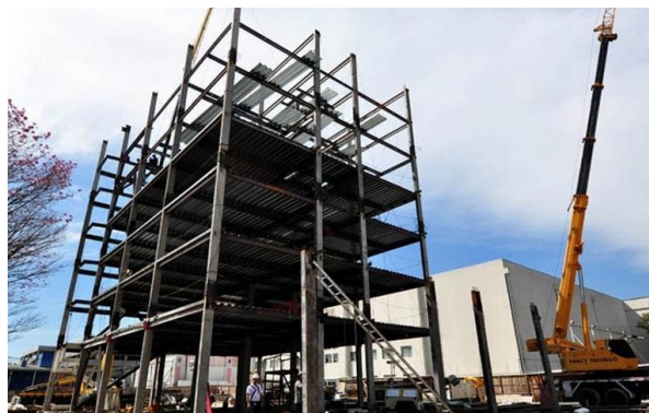
Figura 3 – Montagem da estrutura mista do Hotel Ibis Canoas/RS
