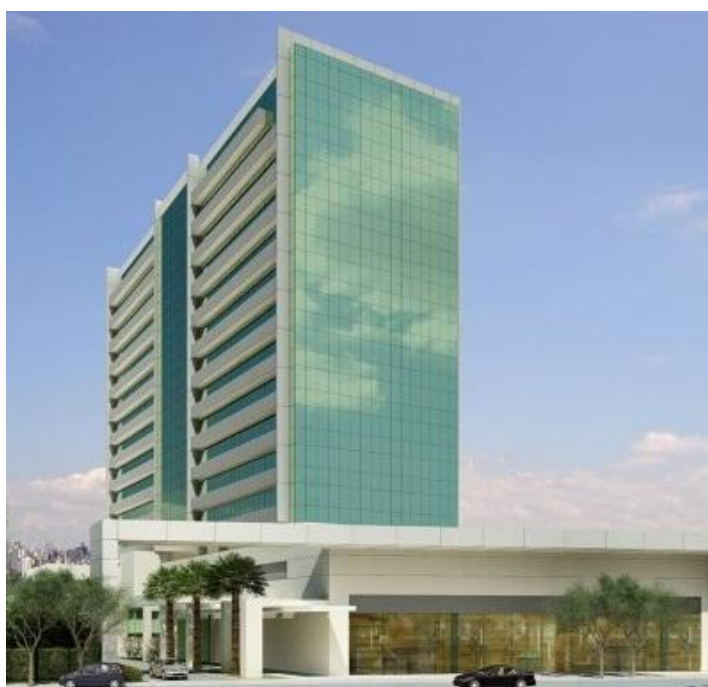
Figura 26 – Fachada da edificação com laje zero
