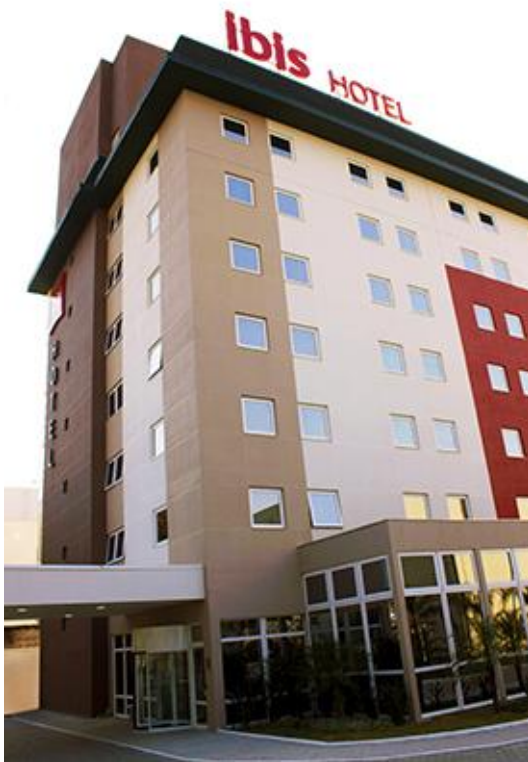
Figura 13 – Fachada do Hotel Ibis
