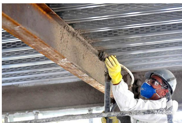
Figura 39 – Aplicação da proteção passiva
