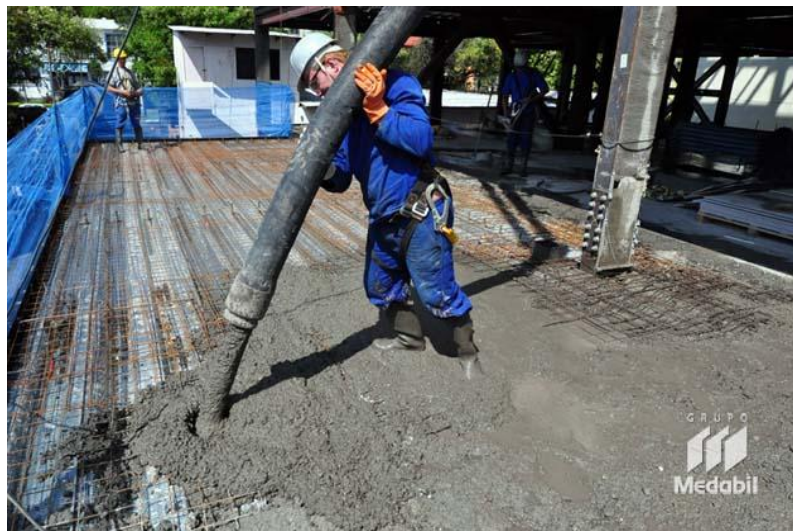
Figura 23 – Lançamento do concreto
