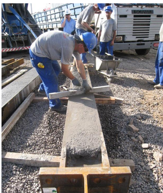
Figura 17 – Pilares mistos previamente concretados
