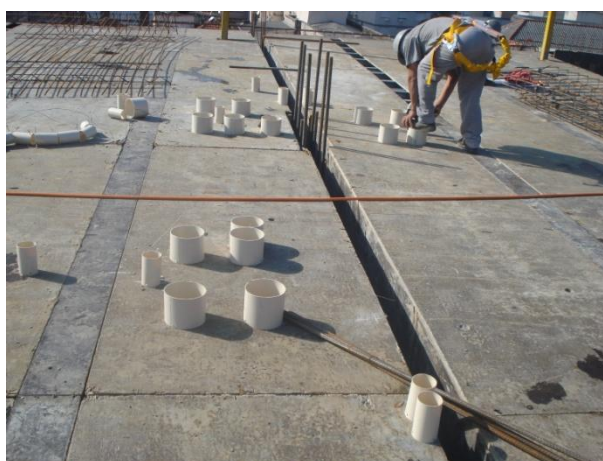
Figura 30 – Colocação de elementos embutidos
