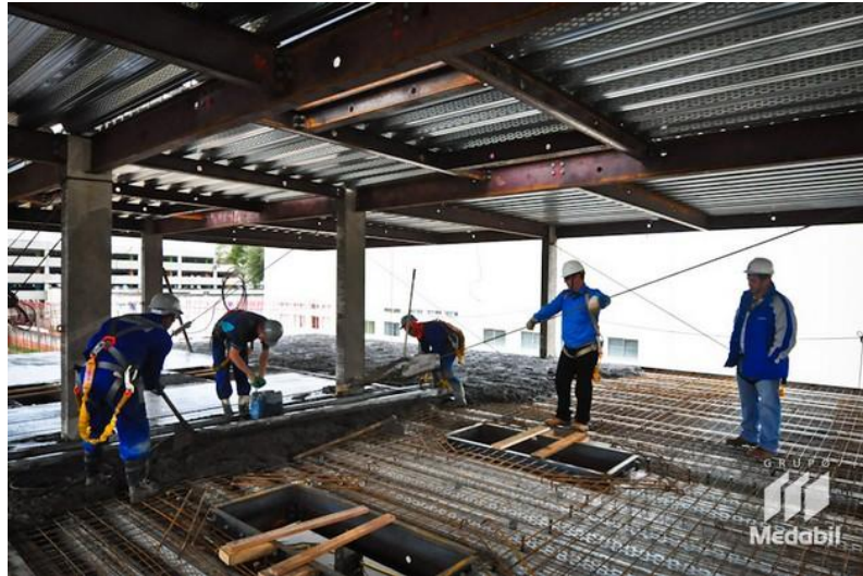
Figura 22 – Preparação do steel deck para a concretagem
