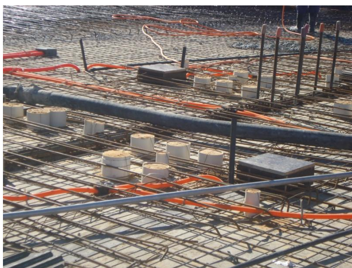
Figura 32 – Laje pronta para a concretagem
