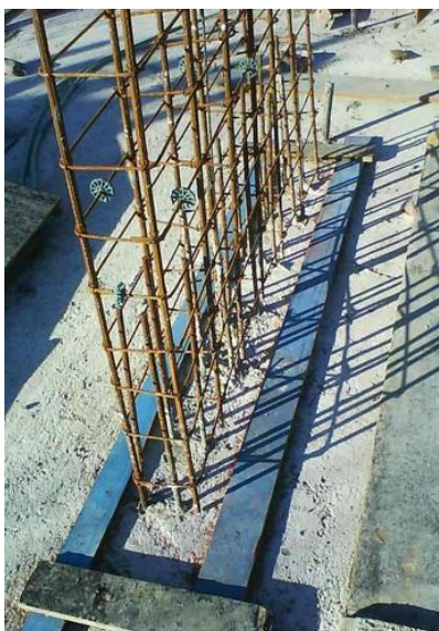
Figura 27 – Montagem dos pilares
