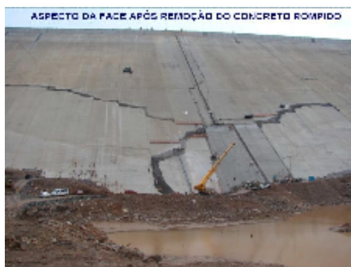
Figura 17: aspecto da face após remoção do concreto rompido
