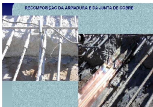
Figura 16: recomposição da armadura e da junta de cobre
