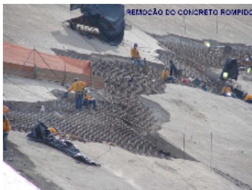
Figura 15: remoção do concreto rompido
