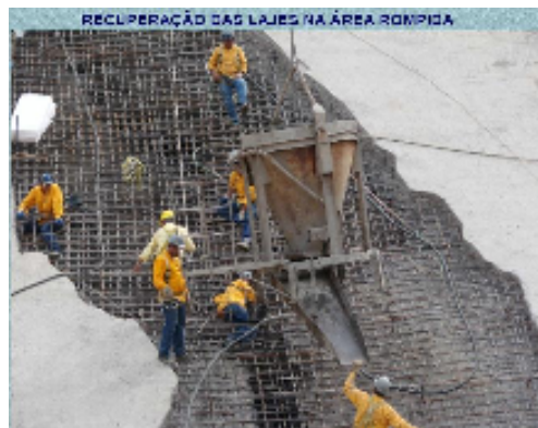
Figura 18: recuperação das lajes rompidas
