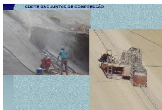
Figura 20: corte das juntas de compressão
