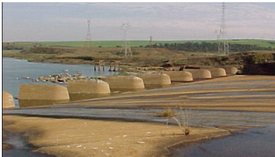
Figura 10: vista geral dos blocos de dissipação – julho/2001 (KORMANN, 2002).
