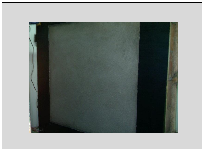
Figura 14 – Painel revestido de argamassa
