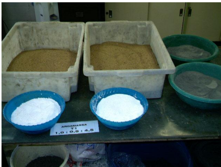
Figura 12 – Preparação dos traços de argamassa
