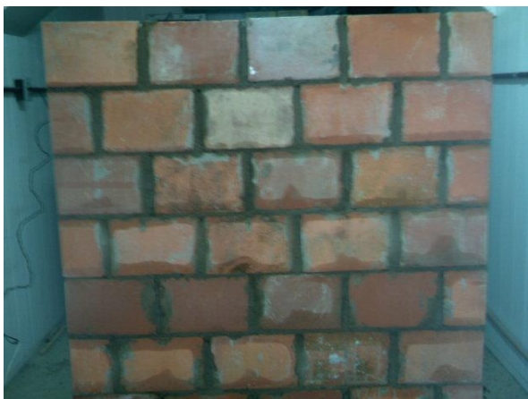
Figura 13 – Estrutura composta de blocos cerâmicos
