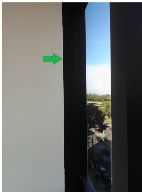
Figura 42 – Parede com o acabamento dos perfis de alumínio
