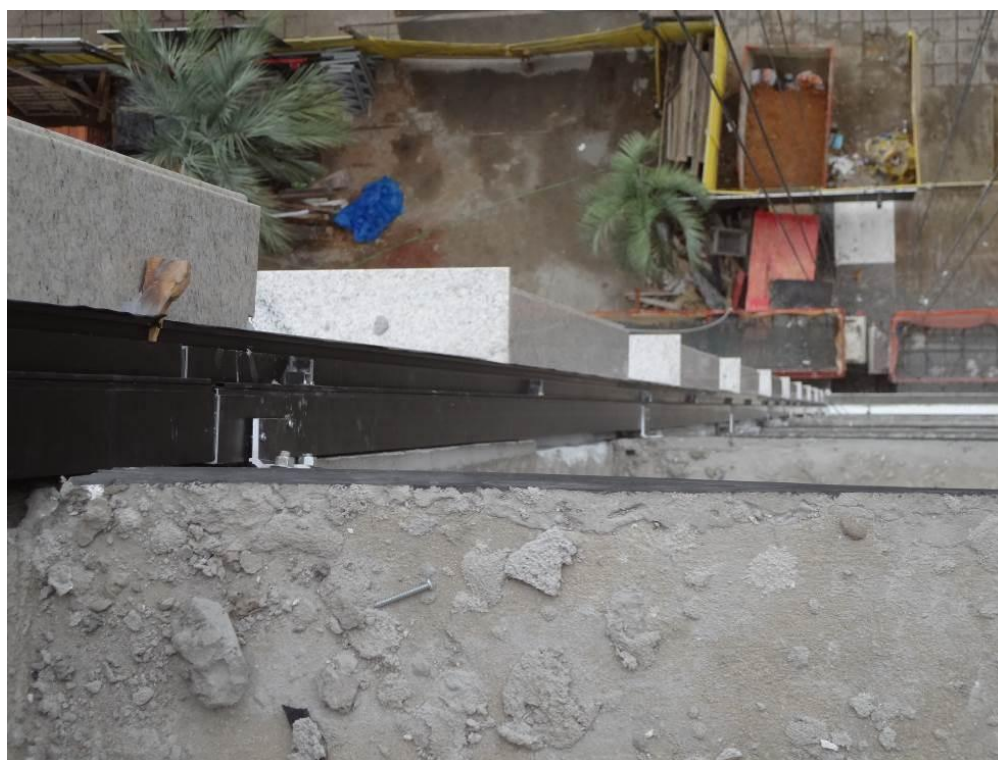
Figura 24 – Fixação da coluna lateral nas lajes de cada pavimento
