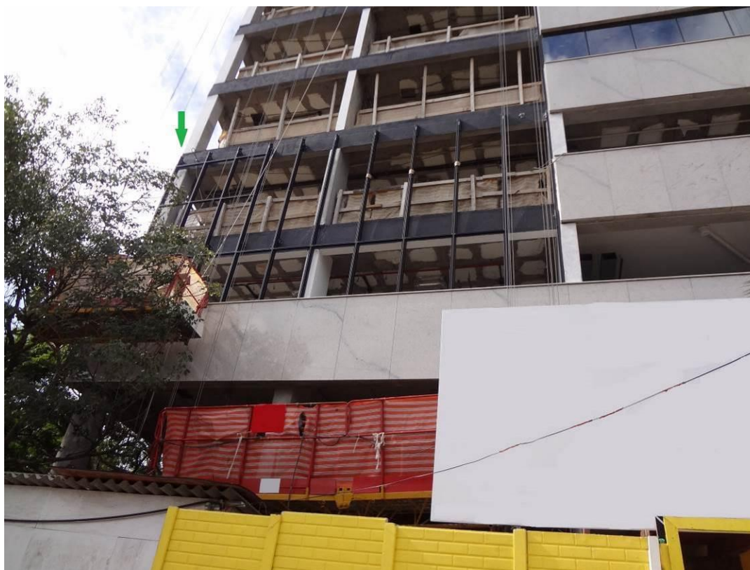
Figura 25 – Primeira coluna instalada sinalizada com a seta
