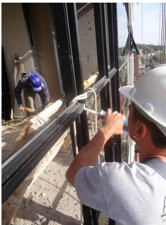
Figura 36 – Impermeabilização das ligações da estrutura
