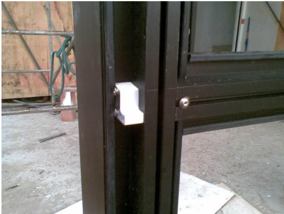
Figura 31 – Suporte fixador da travessa na coluna
