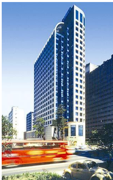
Figura 12 – Edifício Citibank: pioneiro na utilização do sistema structural glazing no Brasil
