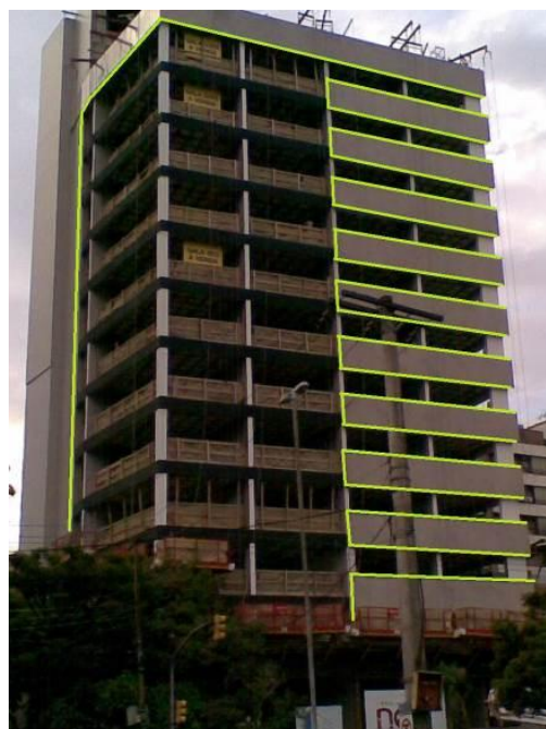
Figura 22 – Ilustração do posicionamento do contramarco
