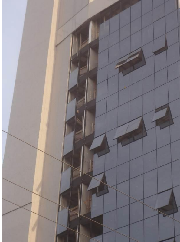
Figura 40 – Localização dos vidros da saída de emergência
