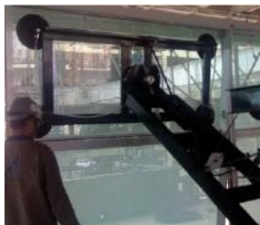
Figura 16 – Içamento interno utilizando minigrua
