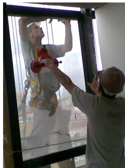
Figura 38 – Utilização da ventosa durante a instalação
