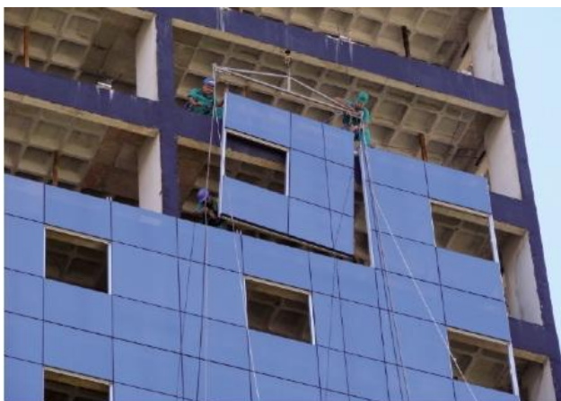
Figura 15 – Içamento externo utilizando guindaste
