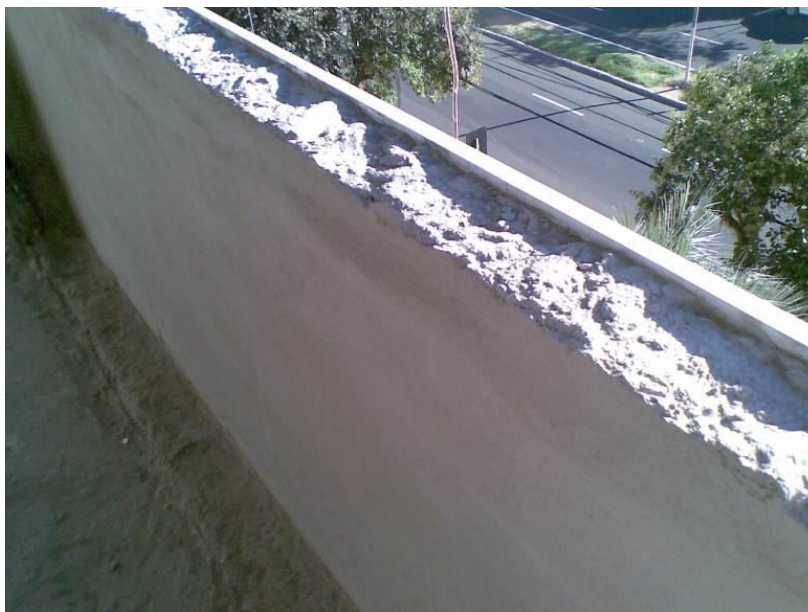
Figura 23 – Quebra do chumbamento do contramarco para correção do nível
