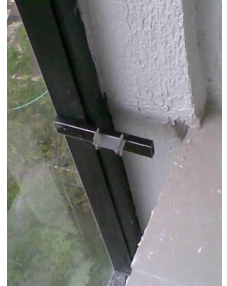
Figura 46 – Perfil fixado na coluna
