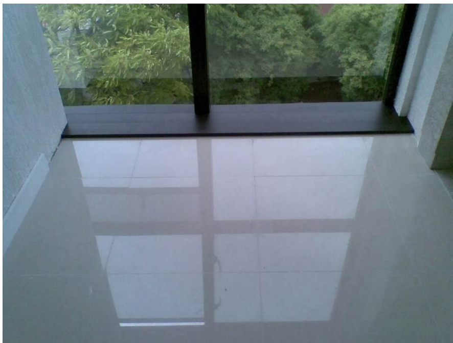
Figura 47 – Aspecto final do fechamento da laje
