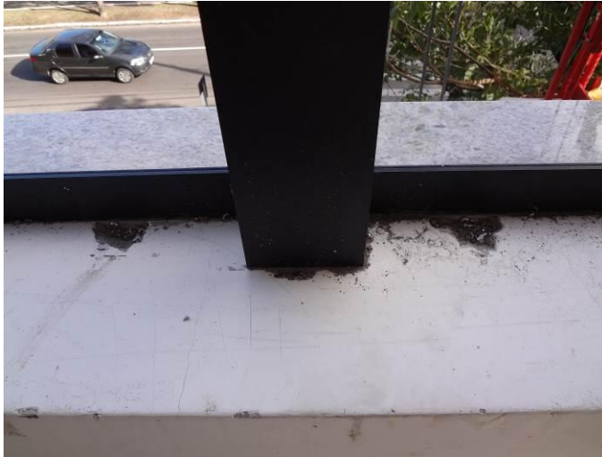
Figura 29 – Fixação das travessas no contramarco
