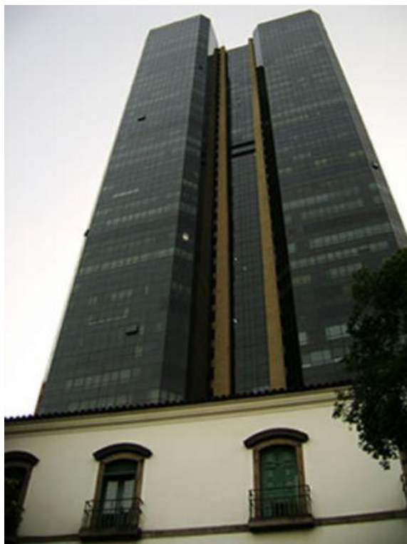
Figura 10 – Edifício Centro Cândido Mendes: primeiro edifício a utilizar o sistema pele de vidro
