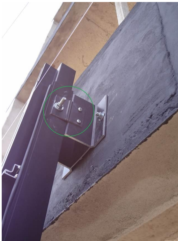
Figura 28 – Fixação da coluna na laje utilizando extensores
