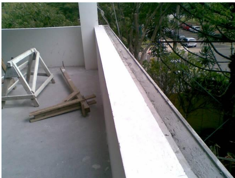
Figura 20 – Peitoril da base da pele de vidro inacabado
