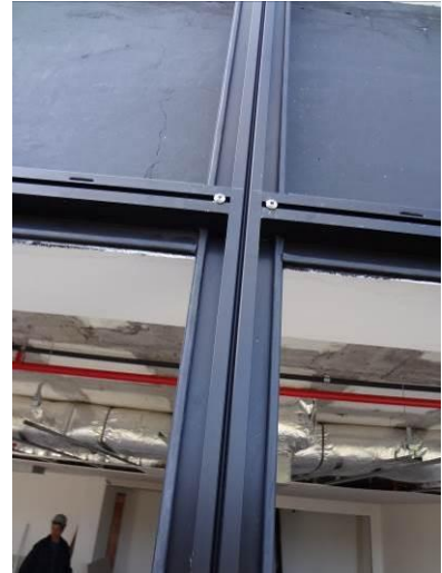
Figura 30 – Fixação das travessas
