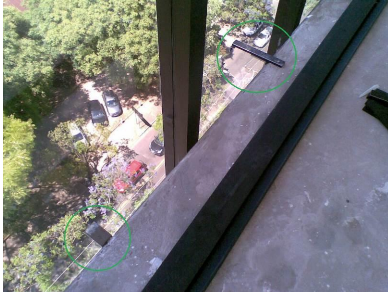
Figura 45 – Perfil tipo L e perfil intermediário fixados
