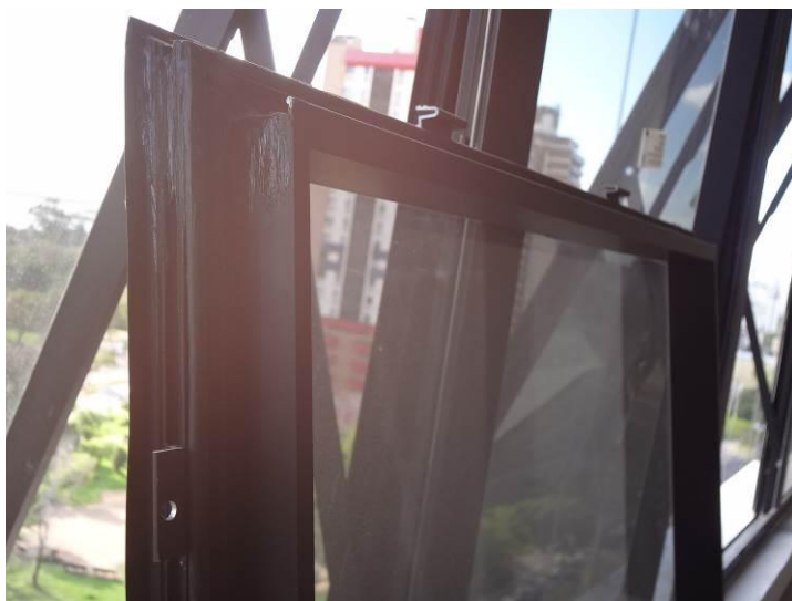
Figura 37 – Espera para o parafusamento do vidro na estrutura
