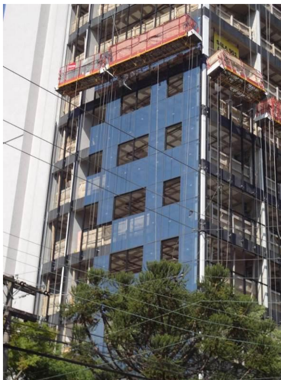
Figura 35 – Primeiro lote de vidros colocados
