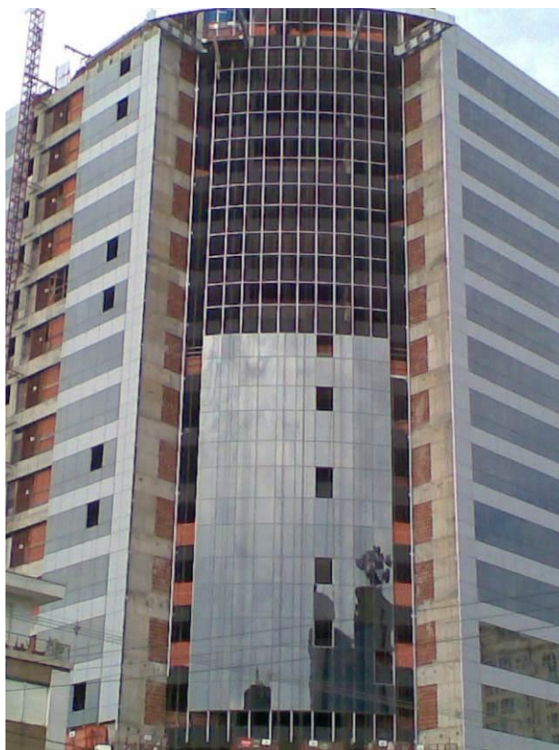
Figura 7 – Execução do sistema stick
