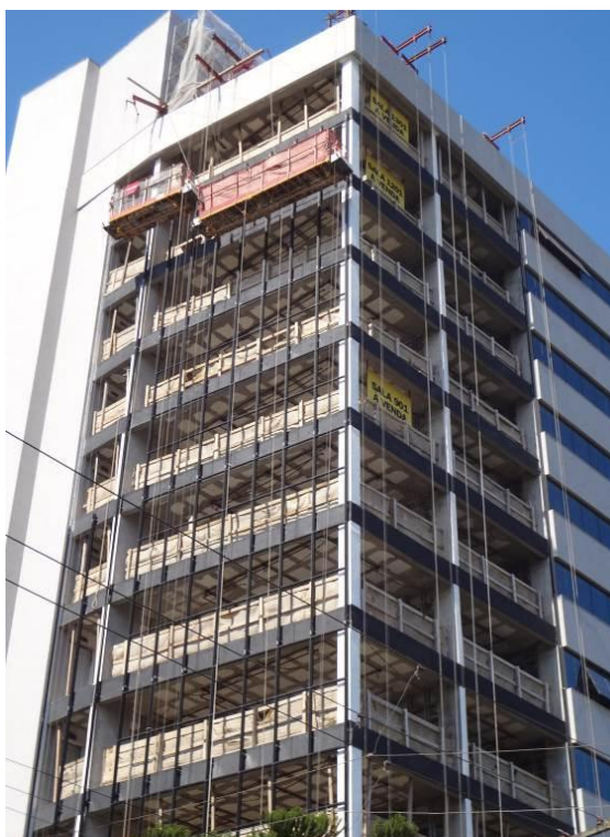
Figura 33 – Estrutura da fachada norte aguardando os perfis sob medida
