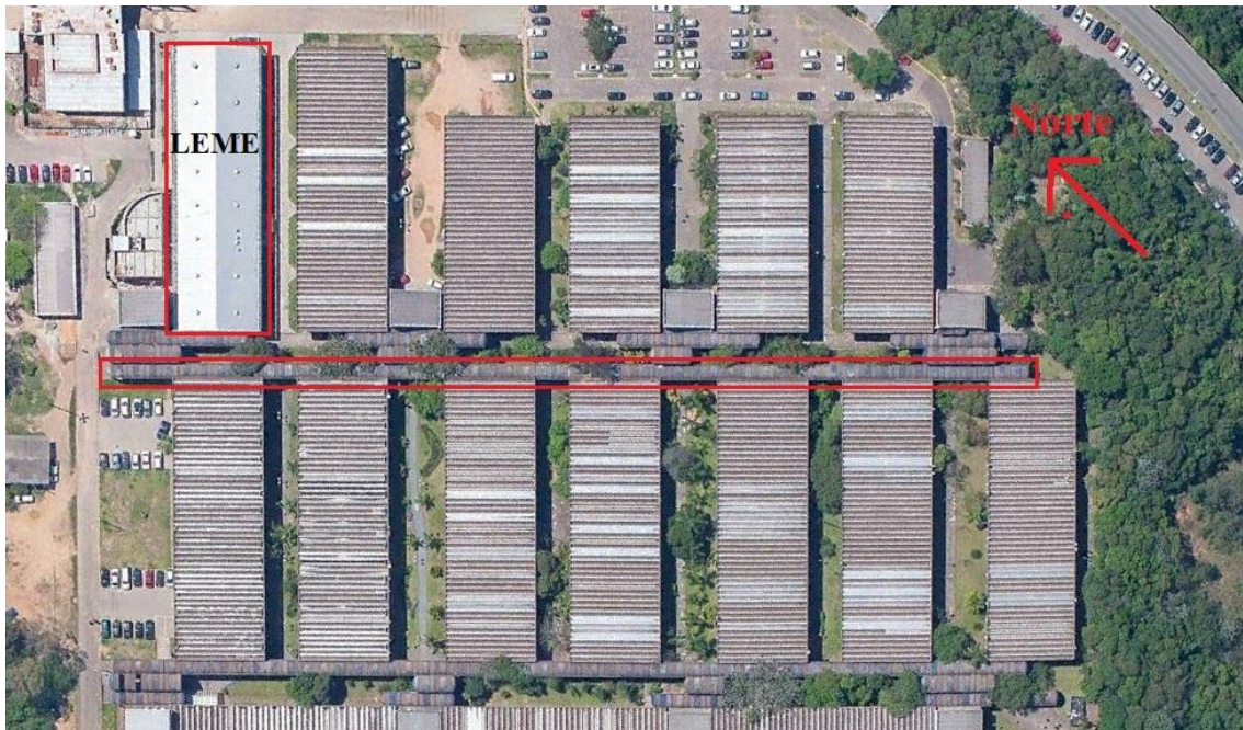
Figura 15 – Localização da passarela escolhida para inspeção
