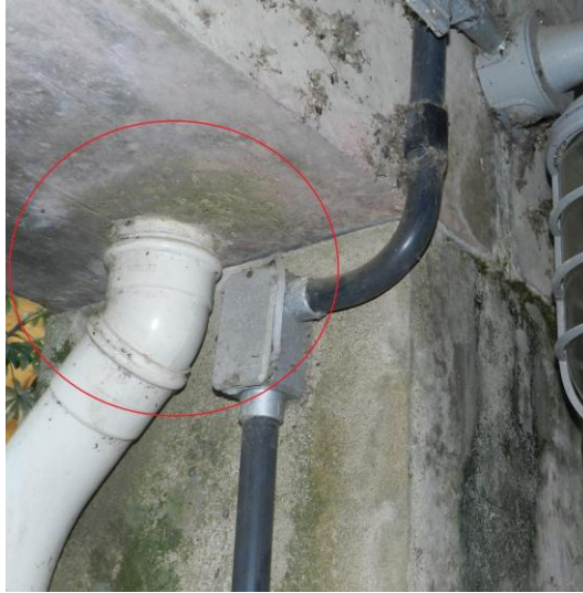
Figura 48 – Detalhe dos tubos de captação de água das calhas
