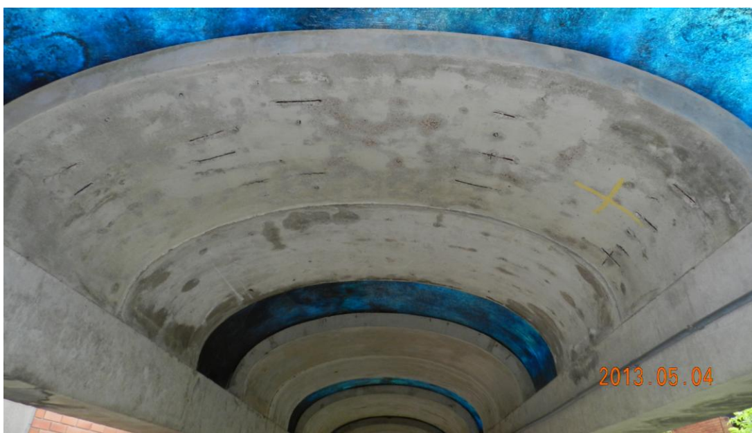
Figura 56 – Vista geral da cobertura 3 do módulo 13
