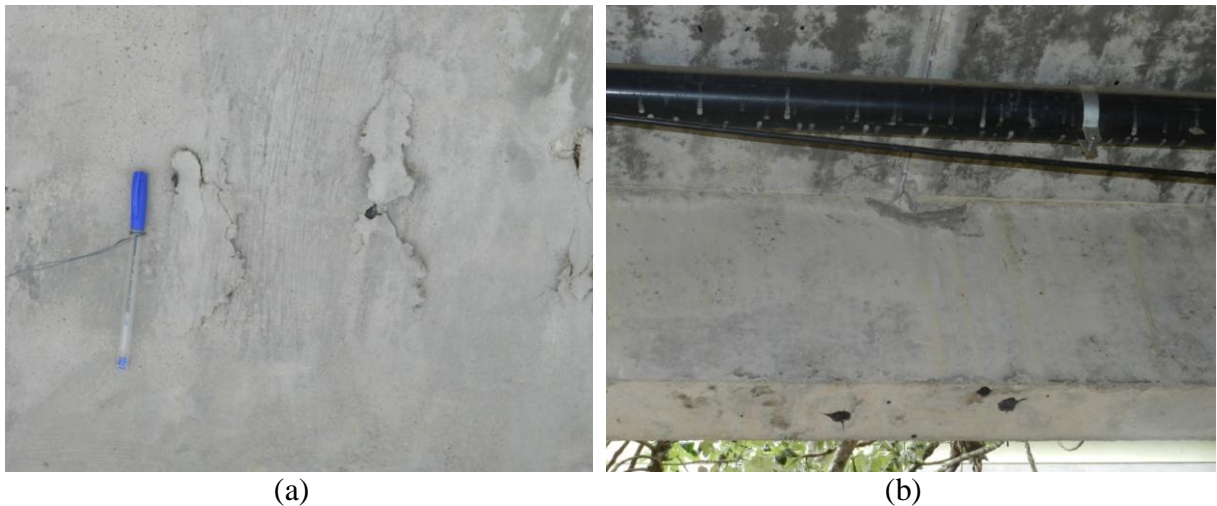
Figura 23 – (a) expulsão parcial de cobrimento e (b) lascamento por choque
