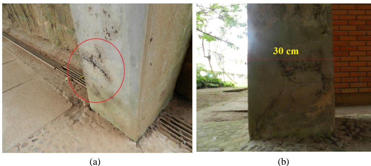
Figura 30 – (a) expulsão parcial do cobrimento no PIE do módulo 11 e (b) PID do módulo 25 com avançado estágio de expulsão parcial do cobrimento
