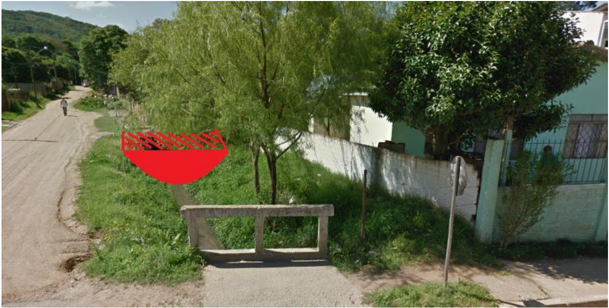
Figura 18 – Córrego com barragem
