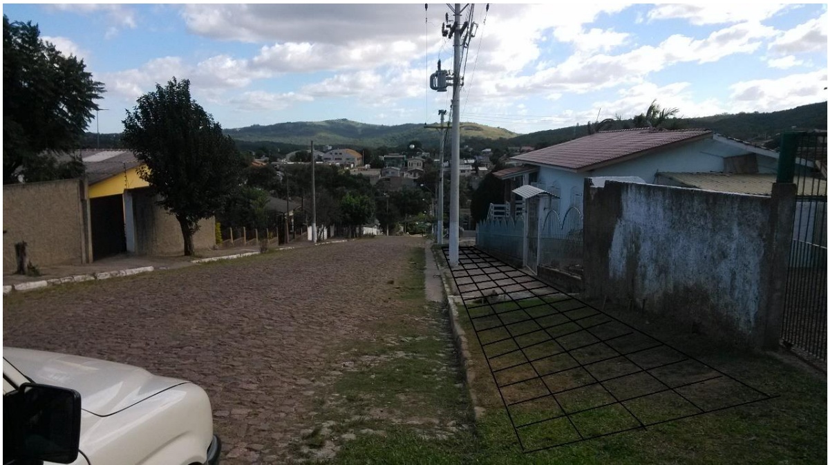
Figura 22 – Calçada com pavimento permeável
