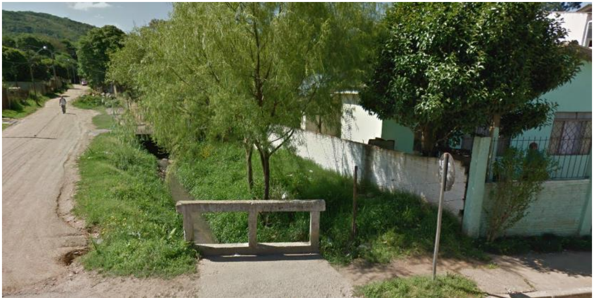
Figura 17 – Córrego na vila Santa Isabel
