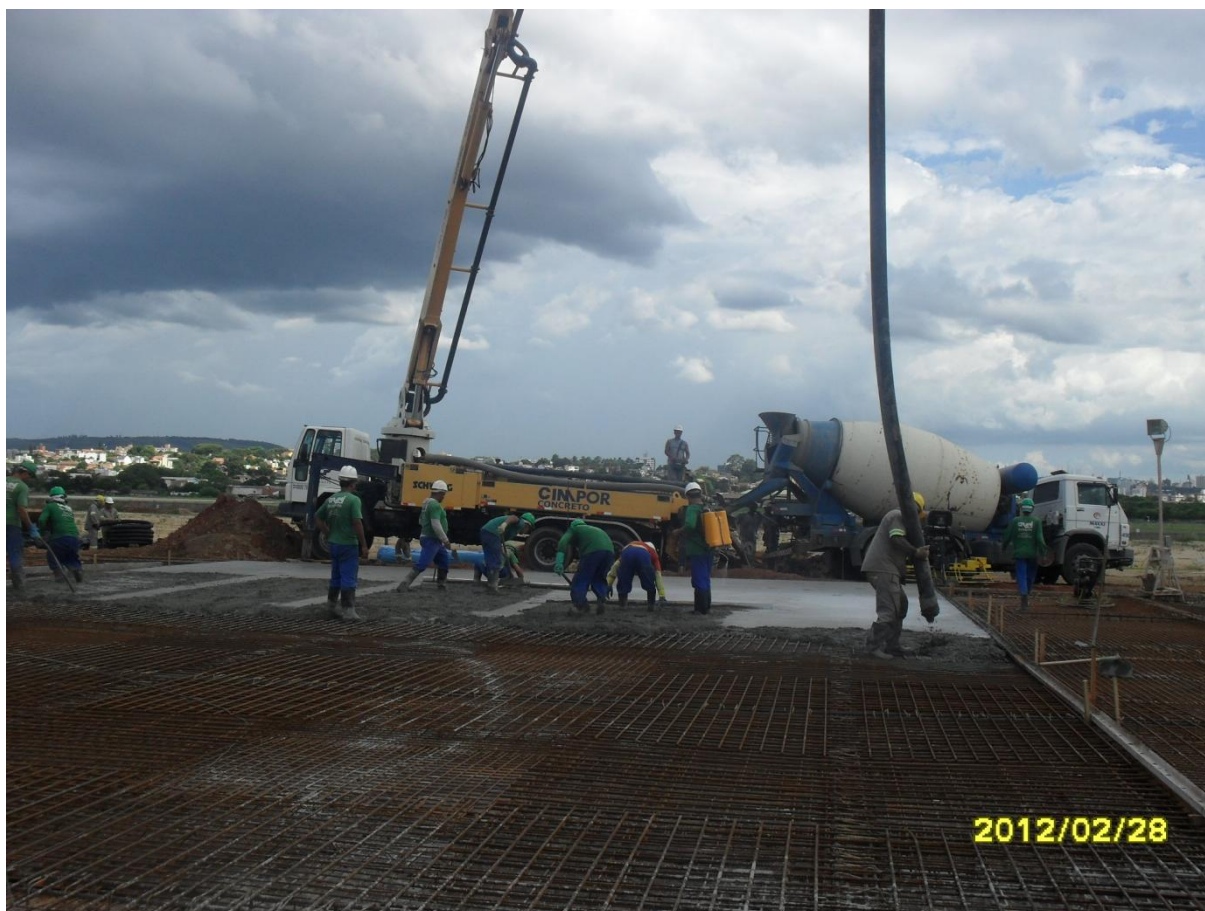
Figura 11 – Lançamento do concreto
