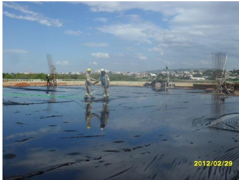
Figura 13 – Cura do concreto
