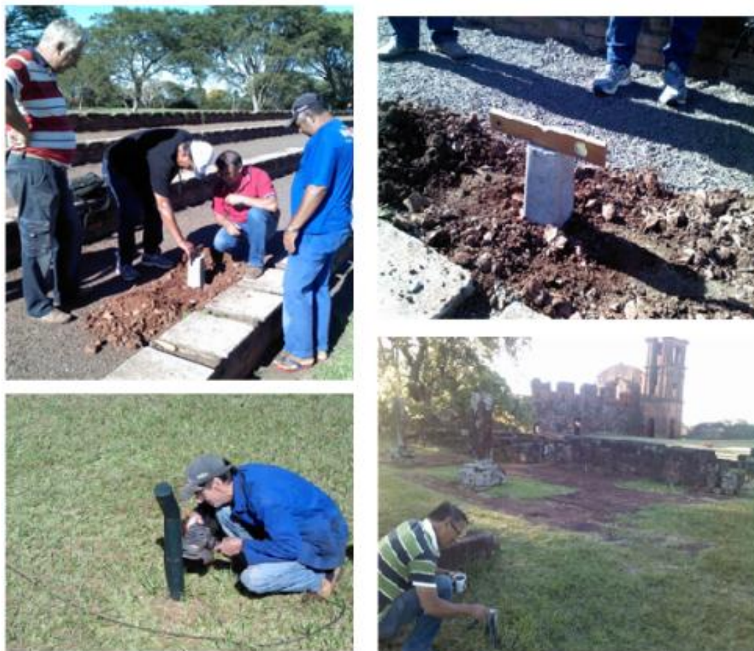
Figura 3-5 - Etapas de implantação da rede geodésica local
