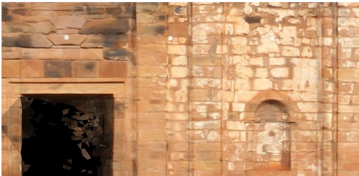
Figura 4-5 - Detalhe da fachada principal
