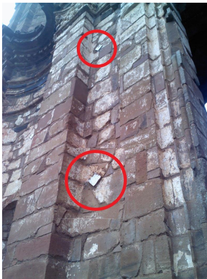
Figura 3-9 – Pontos existentes na fachada principal utilizados como apoio.
