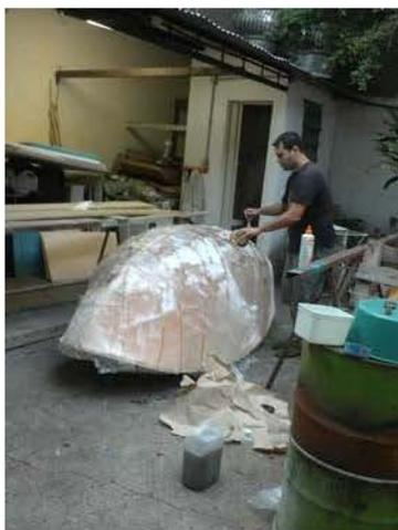
Figura 78: aplicação de tecido de fibra de vidro sobre a armação metálica
