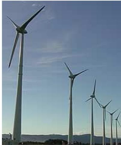
Figura 02 – Aerogerador de três pás
