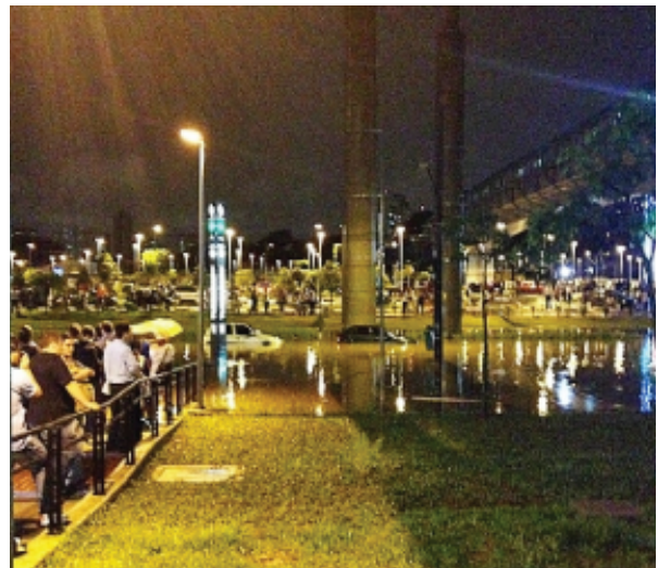
FIGURA 19 - Ponto de alagamento na saída do Metrô Tamanduateí após forte chuva em SP - 01.2013
