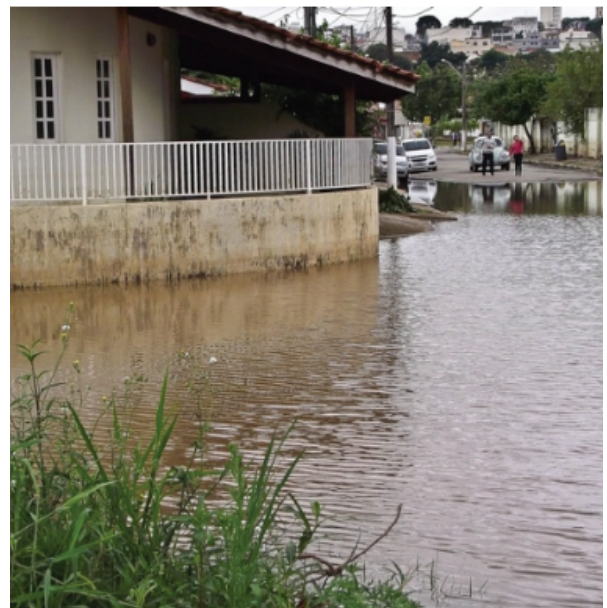
FIGURA 38 - O rio Atibaia transbordou causando enchente - 11.2011
