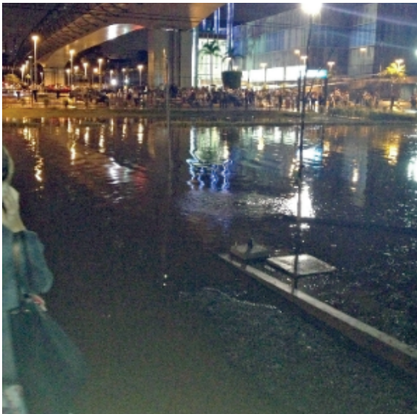
FIGURA 18 - Ponto de alagamento na saída do Metrô Tamanduateí após forte chuva em SP - 01.2013
