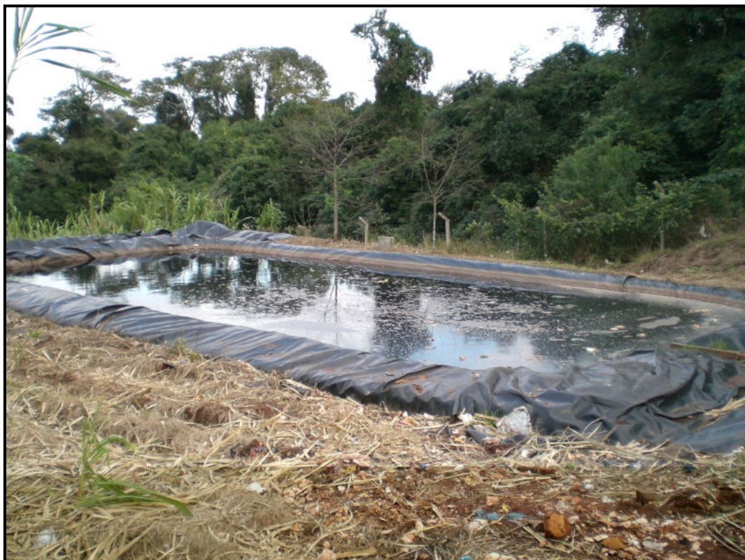
Figura 3.4.: Lagoa de Estabilização de um aterro sanitário.
