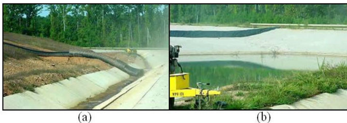
Figura 3.3: Sistema de drenagem de água de chuva. (a) tubo de drenagem que libera a água em um canal de drenagem; (b) tanque coletor que armazena a água canalizada (HowStuffWorks, 2007).
