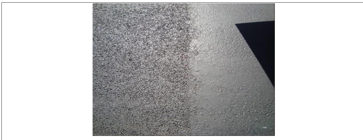
Figura 4.29: Detalhe da textura da superfície na junta transversal (RAUD à esquerda e CA à direita)
