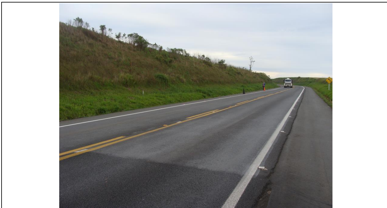
Figura 29: Monitoramento do trecho experimental - vista da textura superficial da seção-teste ( vista do RAUD na parte inferior) e da seção de referência ( vista do concreto asfáltico na parte superior)
