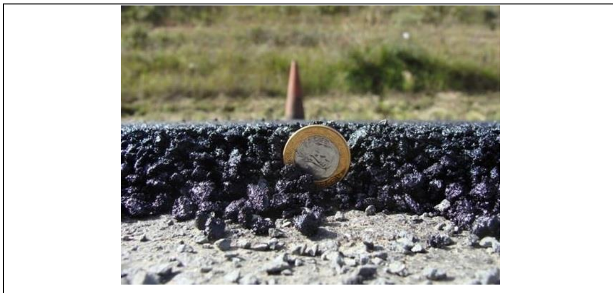
Figura 4.24 (a): Detalhes da espessura e textura superficial do RAUD – espessura final da camada
