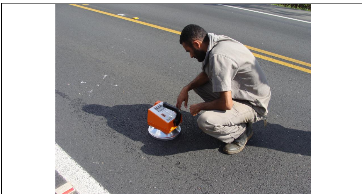
Figura 24: Controle tecnológico – verificação da densidade in situ através do densímetro eletromagnético
