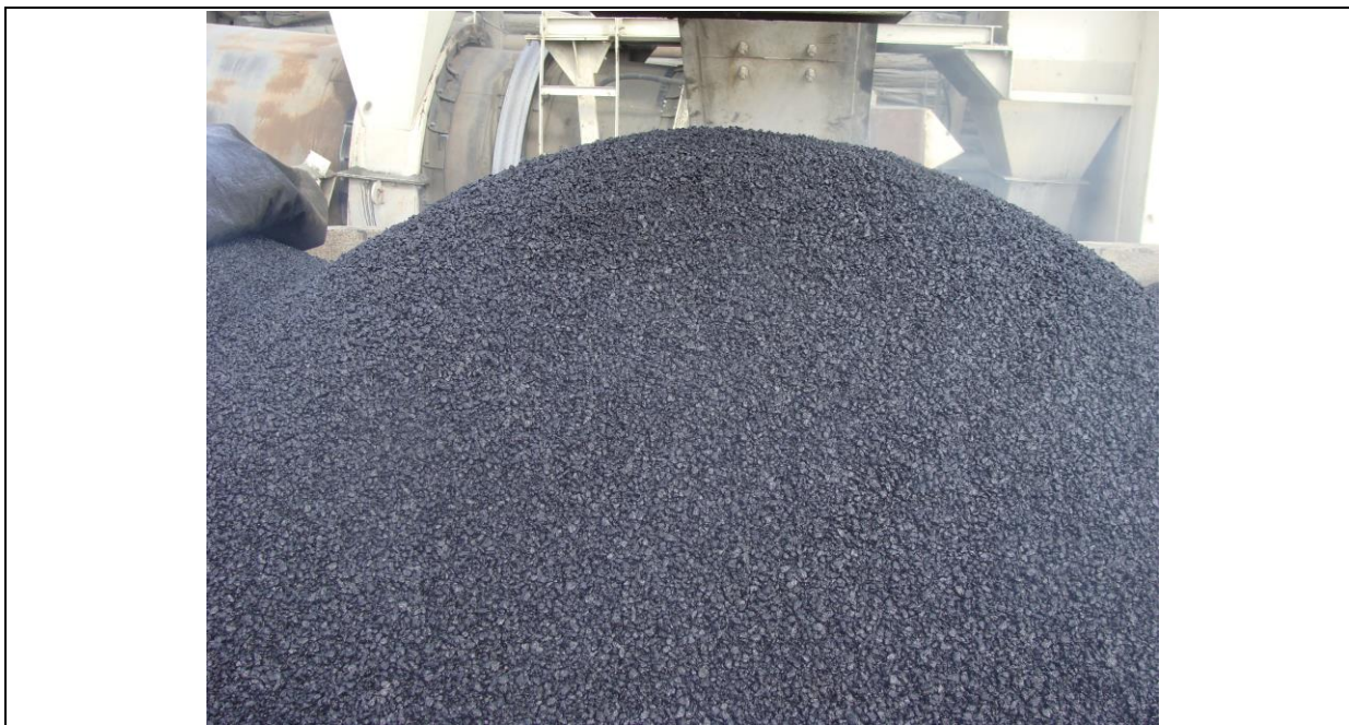
Figura 11: Transporte da mistura - carregamento dos caminhões basculantes
