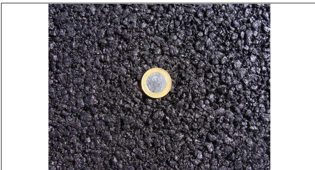
Figura 16: Aplicação da mistura – aspecto da textura superficial da mistura asfáltica durante sua distribuição
