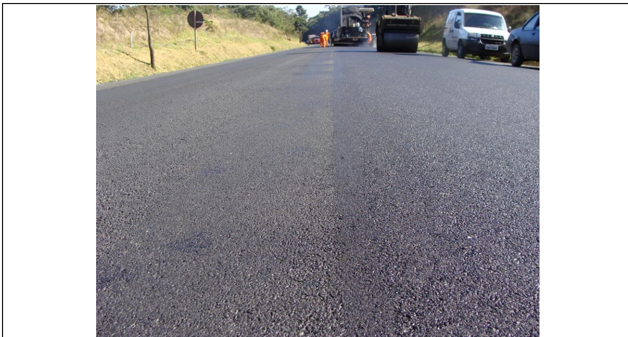
Figura 21: Compactação da mistura – aspecto da junta longitudinal acabada
