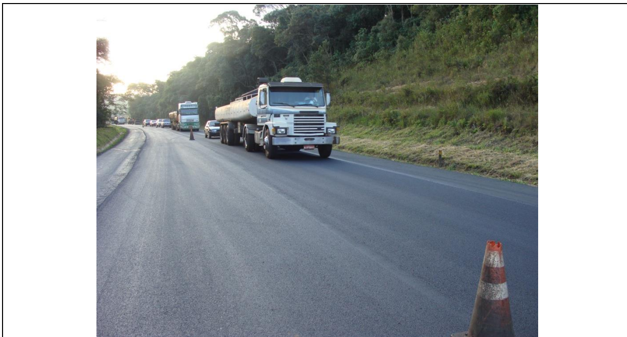
Figura 23: Vista do tráfego sobre o RAUD em meia pista
