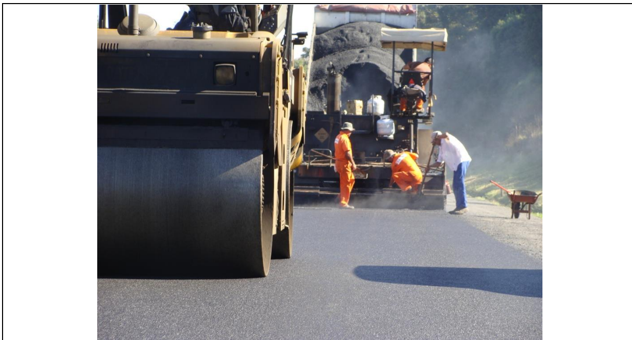
Figura 13: Aplicação da mistura – rolo de chapa imediatamente após a vibro acabadora visando aumentar a eficiência de compactação
