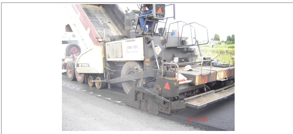
Figura 4.19: Acabadora para espalhamento da mistura asfáltica utilizada no trecho experimental
