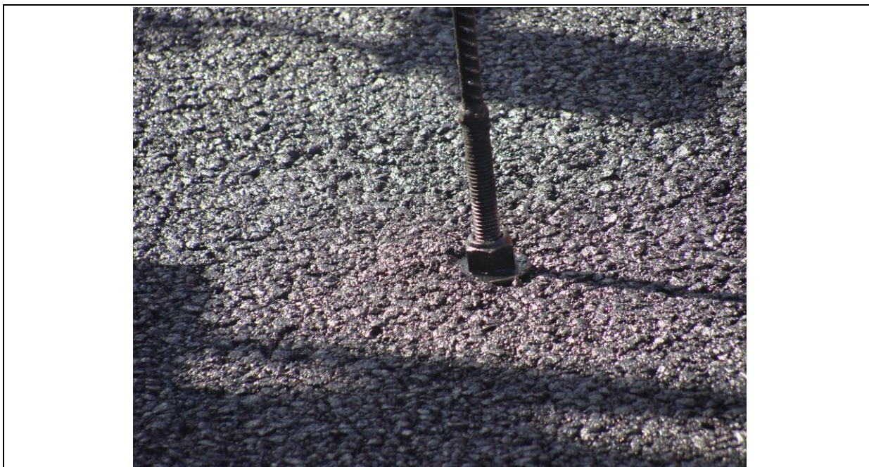
Figura 15: Aplicação da mistura – verificação da espessura durante a distribuição da massa asfáltica
