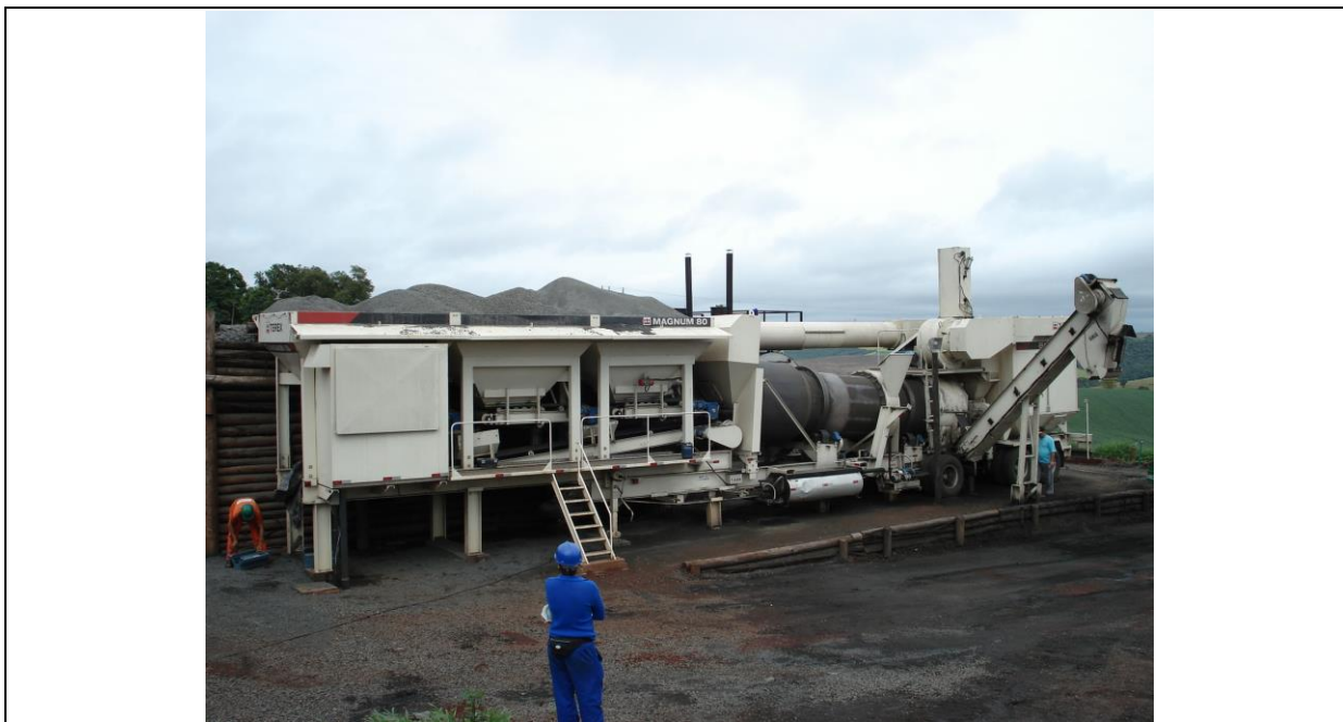
Figura 9: Produção da mistura asfáltica ultra delgada - usina de asfalto contrafluxo
