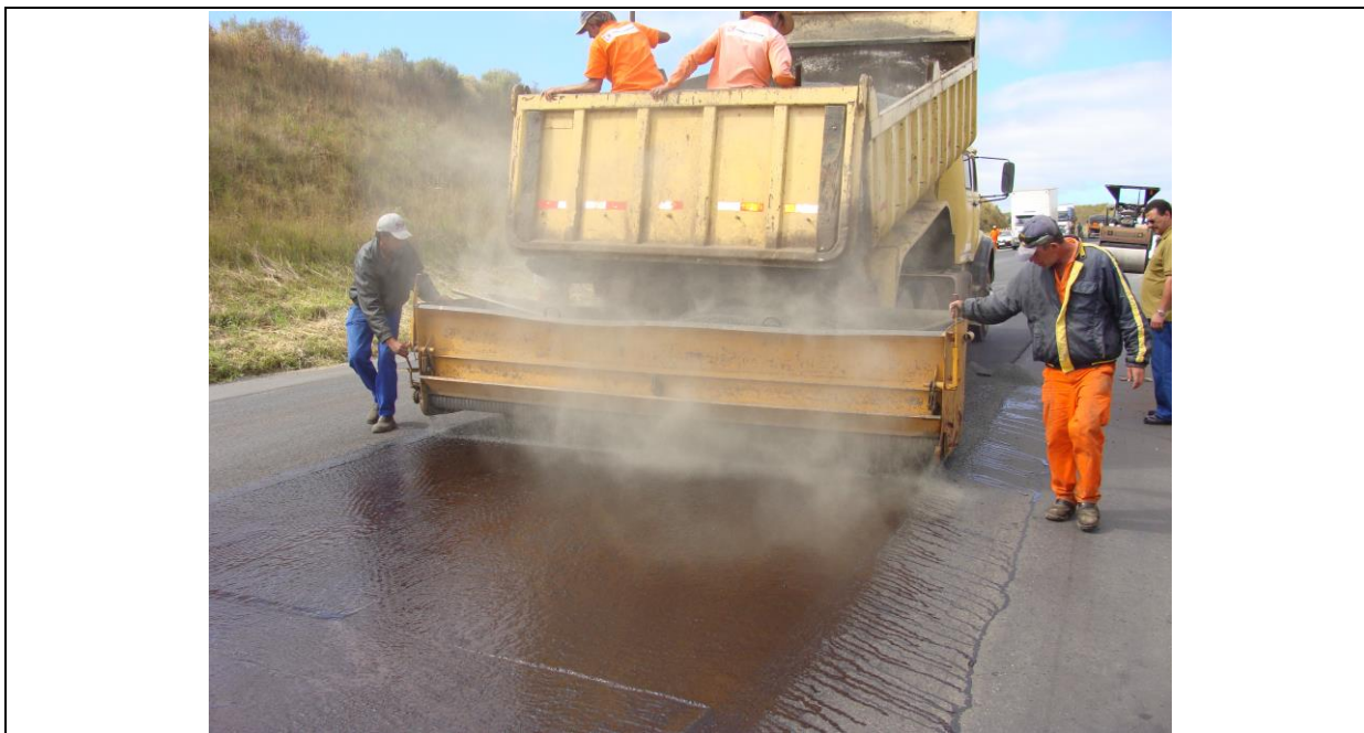
Figura 3: Execução da camada impermeabilizante e de ligação – início da aplicação do agregado 4/6 mm
