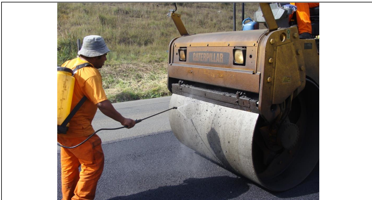
Figura 19: Compactação da mistura – aspersão de emulsão de óleo vegetal para evitar a aderência da massa asfáltica ao rolo de chapa
