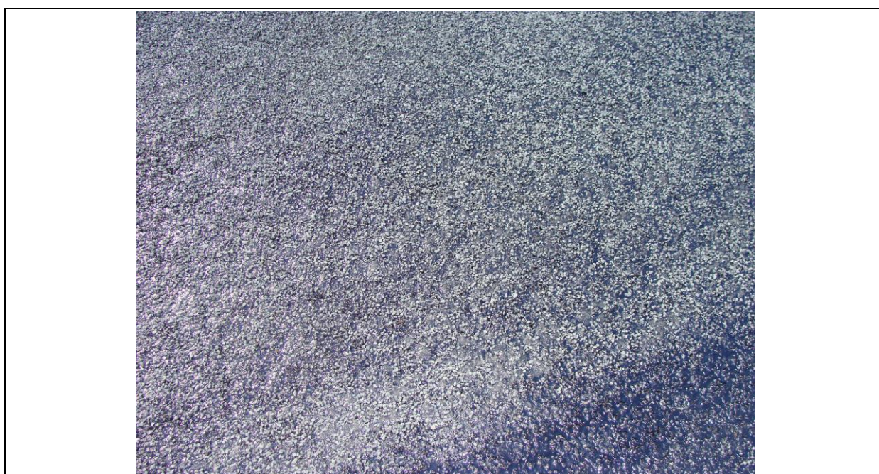
Figura 8: Execução da camada impermeabilizante e de ligação – aspecto da textura superficial
