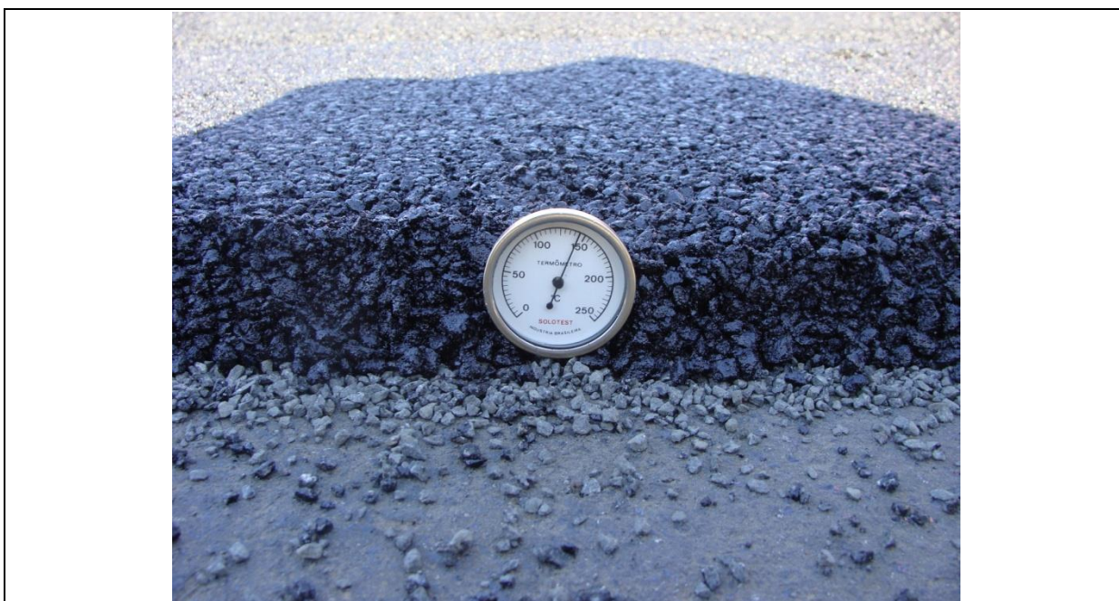
Figura 14: Aplicação da mistura – temperatura da massa asfáltica durante sua distribuição
