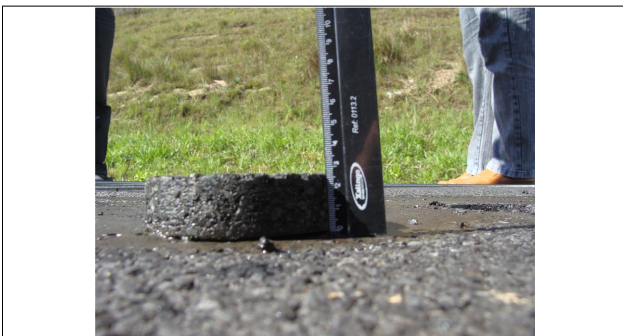
Figura 28: Monitoramento do trecho experimental - verificação da espessura do CP do RAUD
