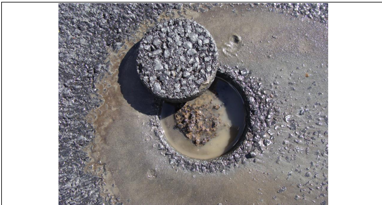
Figura 27: Monitoramento do trecho experimental – extração de CP para verificação de espessura do RAUD
