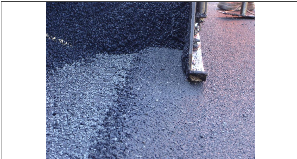
Figura17: Aplicação da mistura – execução da junta longitudinal
