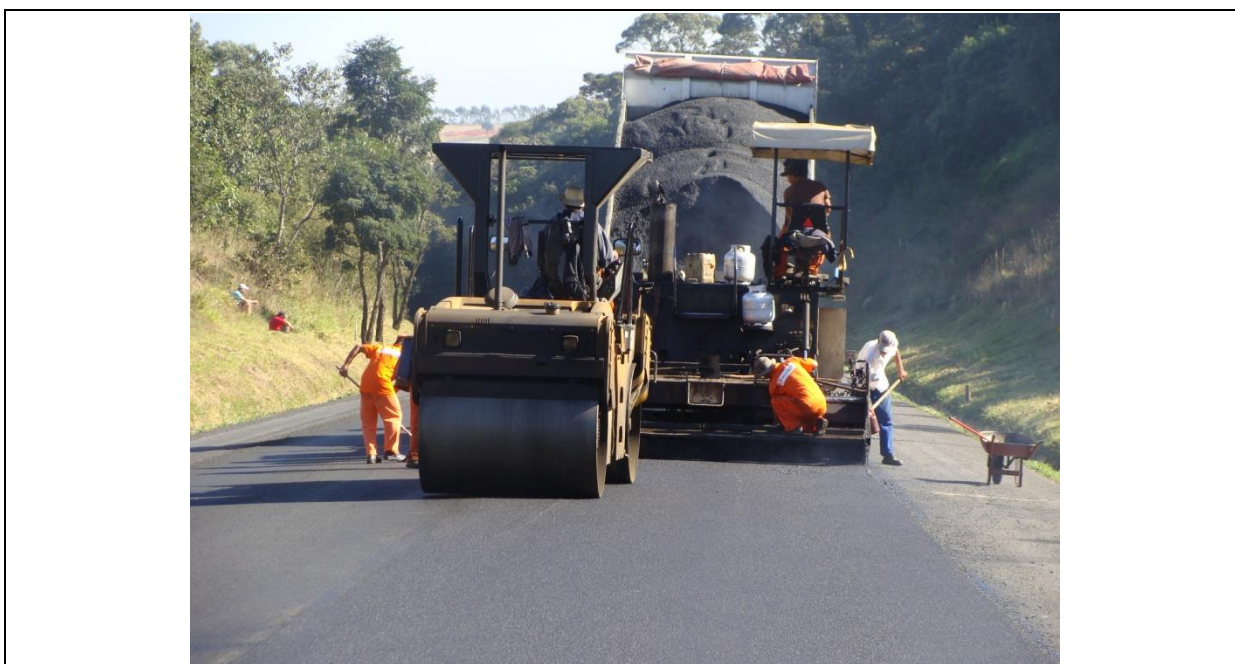
Figura 20: Compactação da mistura – rolagem da junta longitudinal
