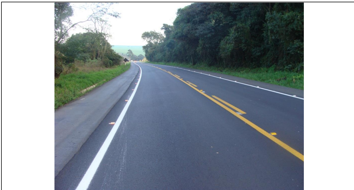
Figura 25: Vista do trecho experimental sinalizado
