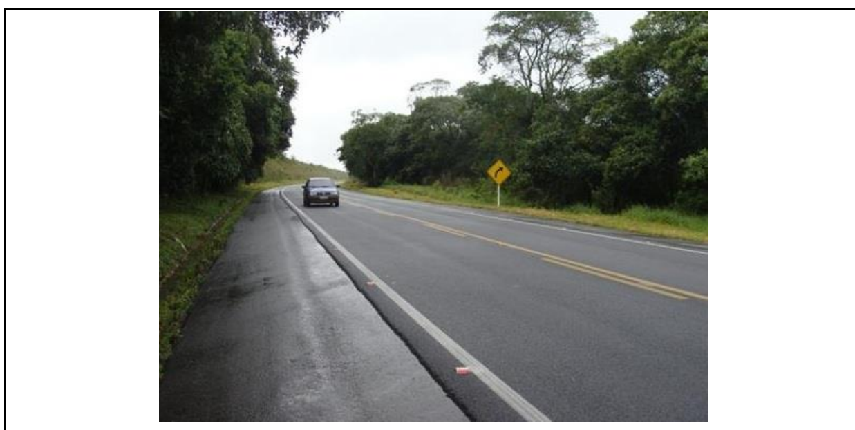
Figura 4.26 (b): Aspecto final da rodovia após a sinalização horizontal do RAUD – pista úmida
