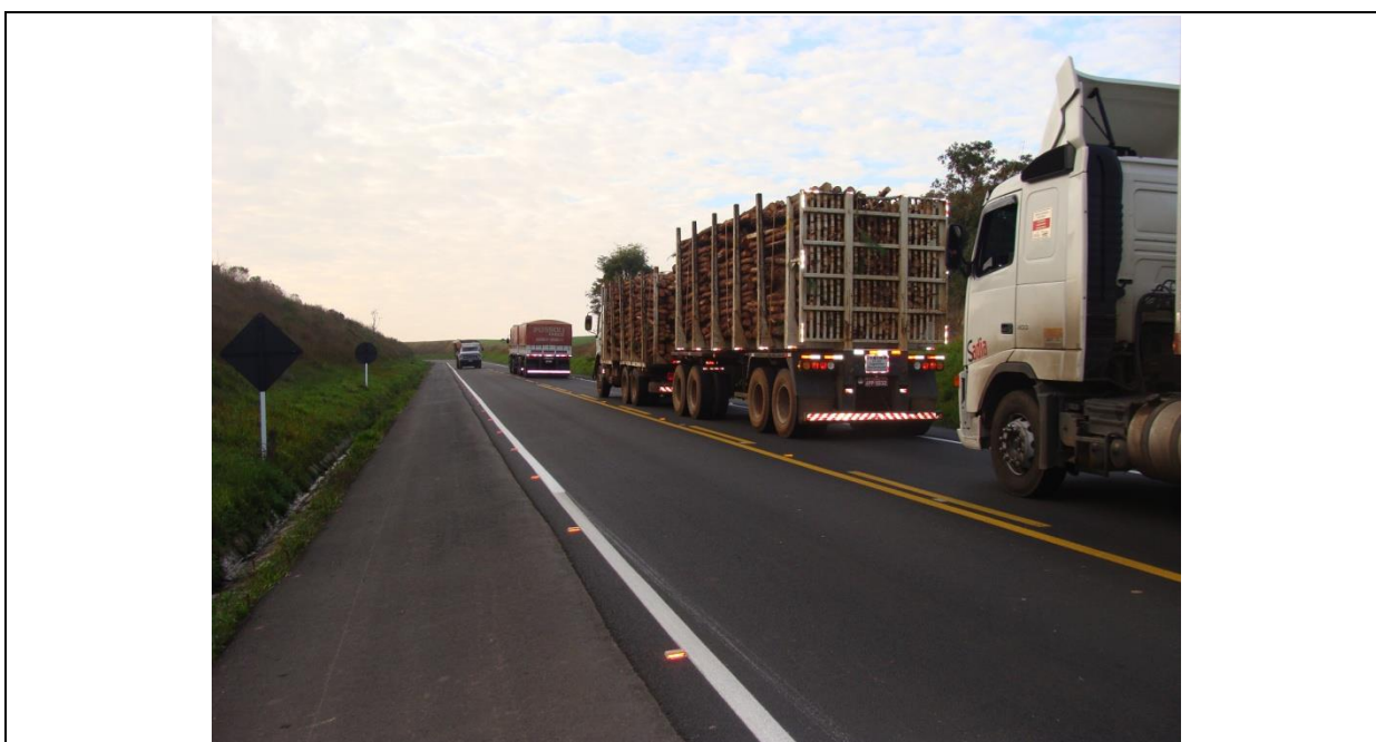
Figura 26: Vista do trecho experimental sinalizado e liberado ao tráfego
