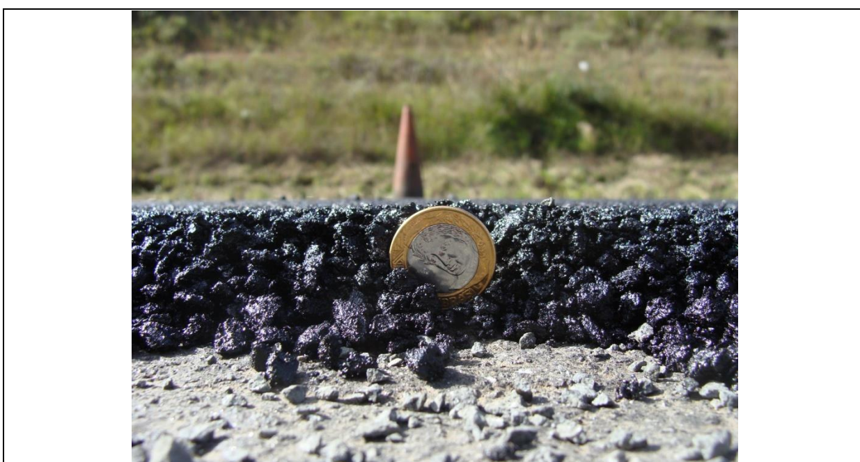
Figura 22: Compactação da mistura – aspecto da espessura média do RAUD (20 mm) após a compactação
