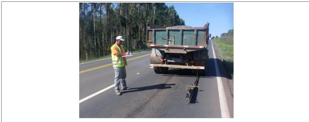
Figura 4.30: Avaliação deflectométrica de campo com a viga Benkelman no trecho experimental
