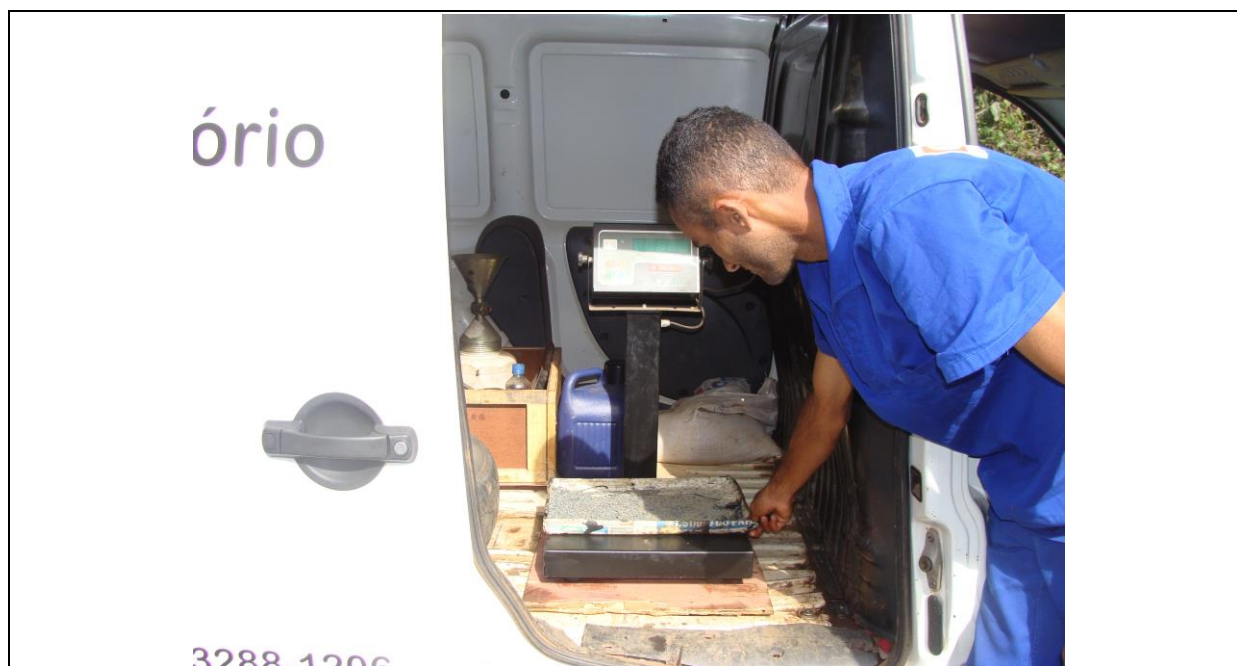
Figura 7: execução da camada impermeabilizante e de ligação – pesagem da bandeja para verificação da taxa de agregado 4/6 mm
