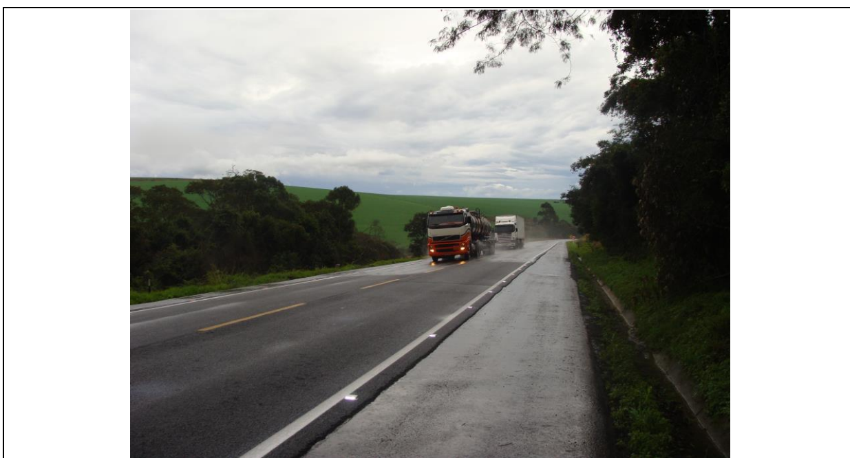
Figura 30: Monitoramento do trecho experimental – aspecto da lâmina de água superficial sobre a seção de referência (vista do concreto asfáltico na parte superior) e na seção-teste (vista do RAUD na parte inferior)
