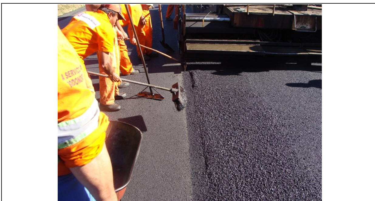
Figura 18: Aplicação da mistura – aspecto do acabamento manual da junta longitudinal
